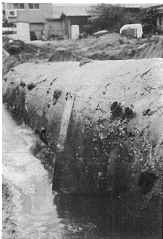
今回の地震によって被災した後にオイルタンクを掘り返したところ 銅帯を基礎に固定していたボルトが抜けている。
