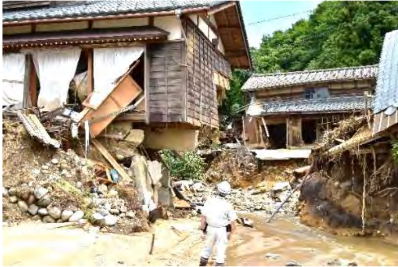
写真1 村上市小岩内地区の家屋への土石流被害 （写真提供：村上市）
