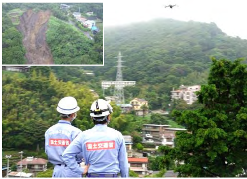
写真7 ドローンによる 土砂崩壊源頭部の調査
