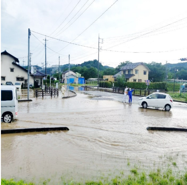
写真1 国道の浸水状況
