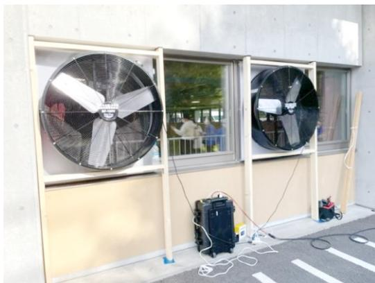
写真7 直径1mの換気ファン2機
