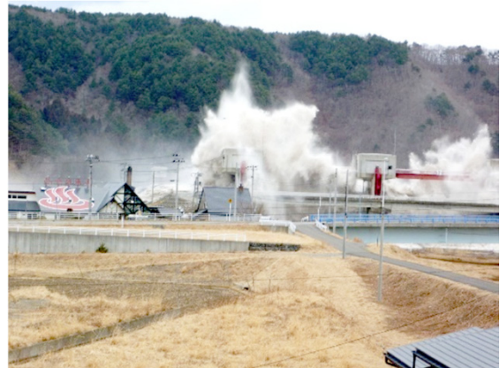
写真1 小本地区に津波襲来した様子
