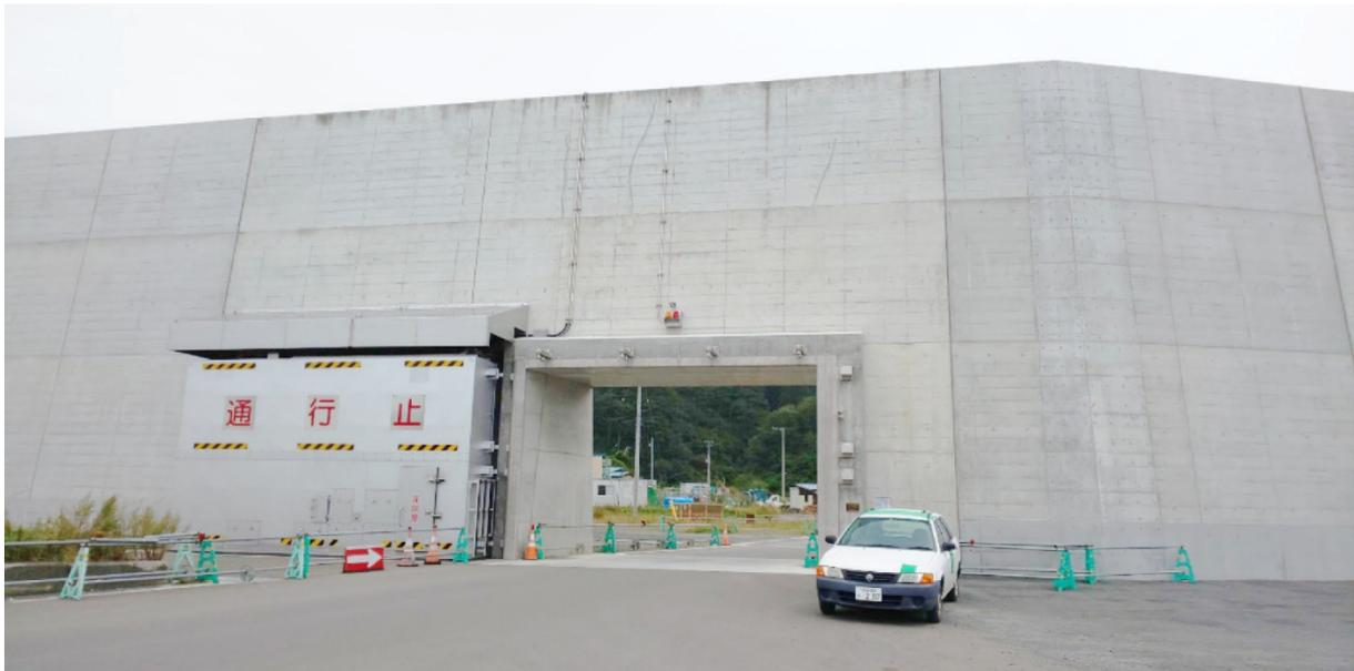
写真1 高さ 14.7m の堤防と自動化された陸閘
