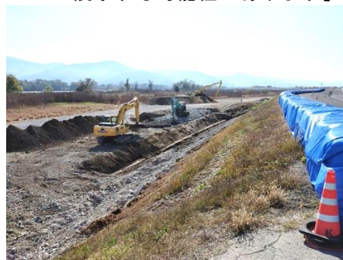
写真9 溢水高さまで堤防の仮工事 を行っている（将来的に堤防のかさ 上げが予定）
