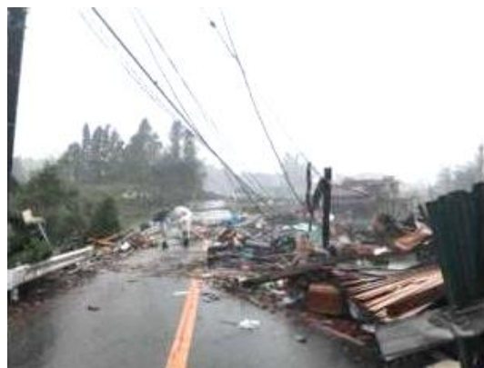
写真2 市原市の様子（台風19号被災後）
