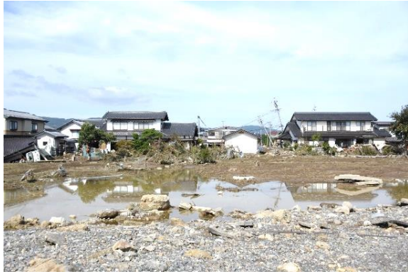
写真 2 千曲川が決壊した長野市穂保の住宅地。街並み全体が傾くほどの被害をもたらした（筆者撮影）
