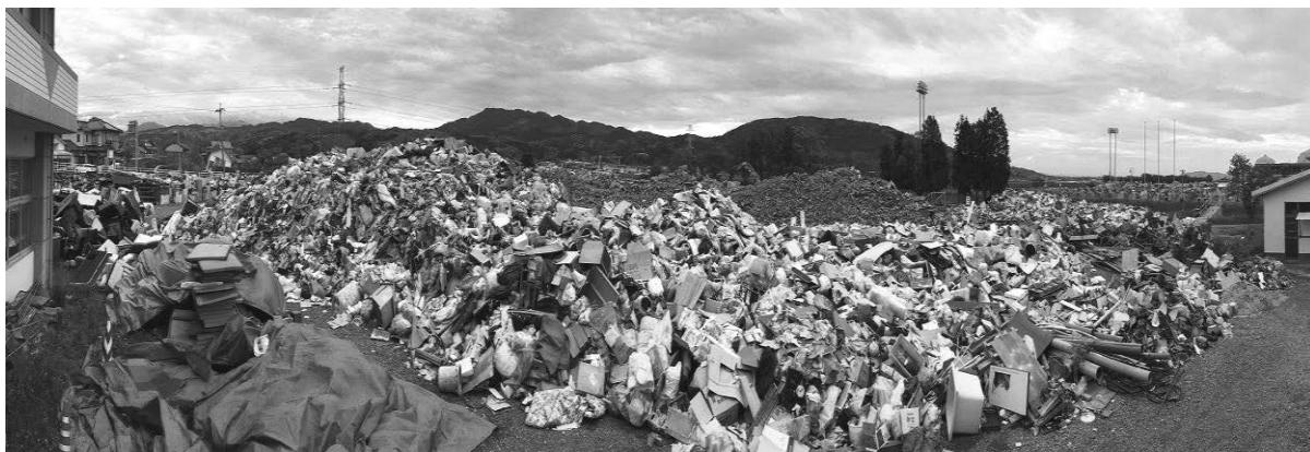
写真1 分別がなされず、混合廃棄物で埋め尽くされた仮置場
