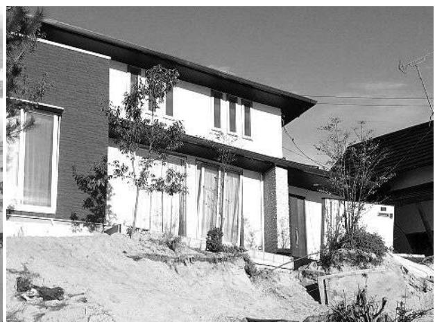
写真2 宅地内への土砂流入
