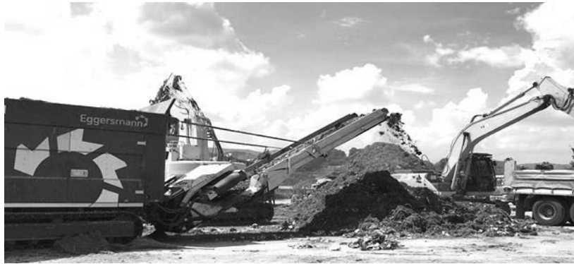
写真 2 倉敷市の 2 次仮置き場に配置された畳専用の破碎機
