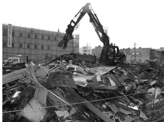
写真6 大型重機による積み込み
