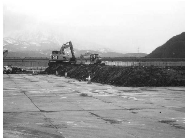
写真 4 仮置き場の作業状況
