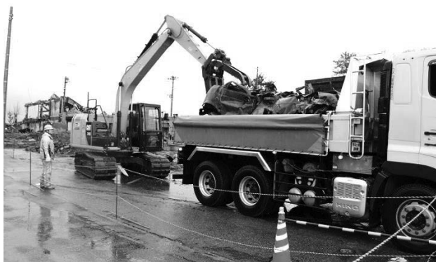
写真5 車両による運び出し
