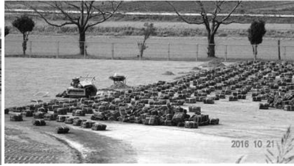
写真6 仮置場として使用した野球場の原状復旧
