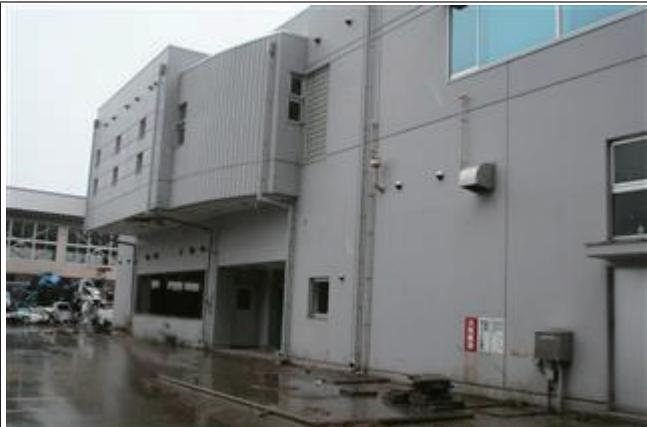
1 階部分の部屋は完全に使用不能となった。窓枠も外れている。(H23/4)
