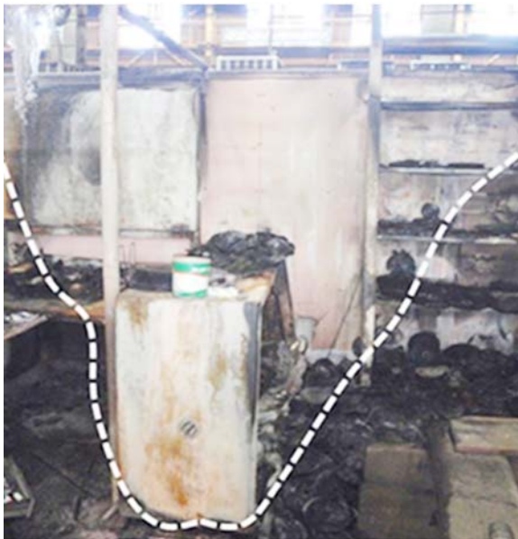
写真2 スチール棚周囲の焼損状況
