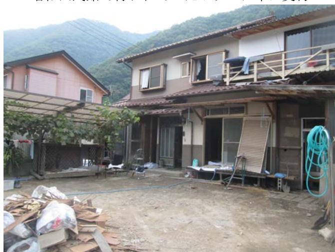
浸水した住宅（１）
