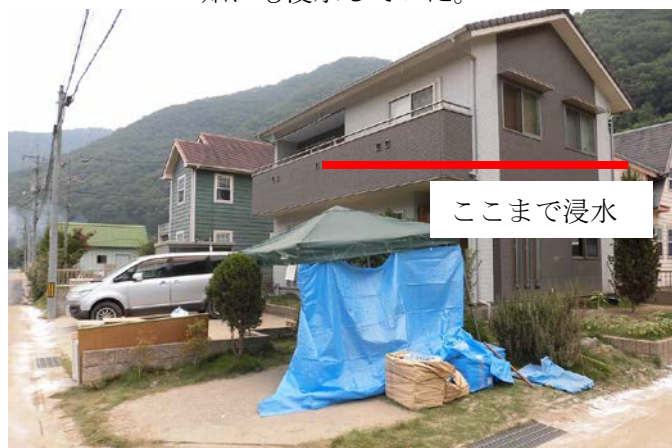
浸水した住宅（２）
