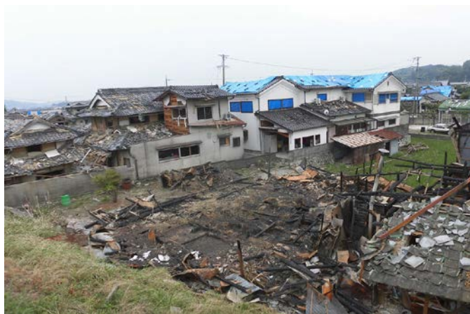
アルミ工場付近（河川敷の向かい側）の住家被害(1)
