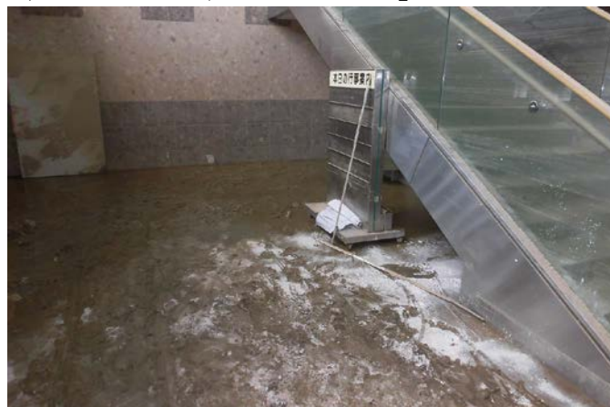
浸水による汚泥が残ったままの 真備保健福祉会館 1 階入口
