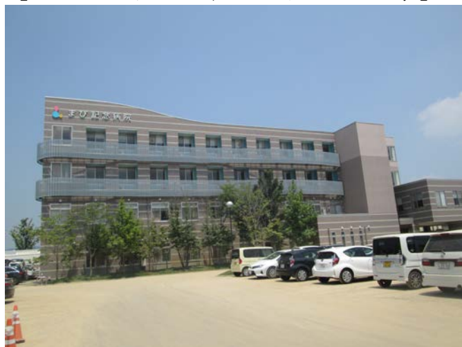
浸水で設備などが使えなくなったまび記念病院 (調査の時点では復旧のめどは立っていなかった)
