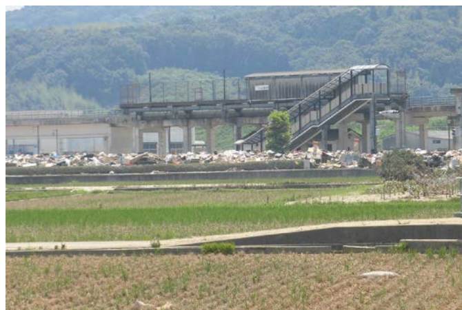
川辺宿駅周辺の被害（その２） （道路の両側に災害ゴミが溢れていた。）
