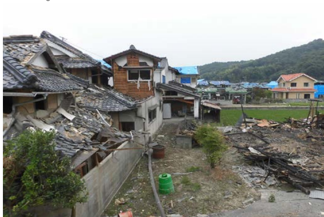
アルミ工場付近（河川敷の向かい側）の住家被害(2)
