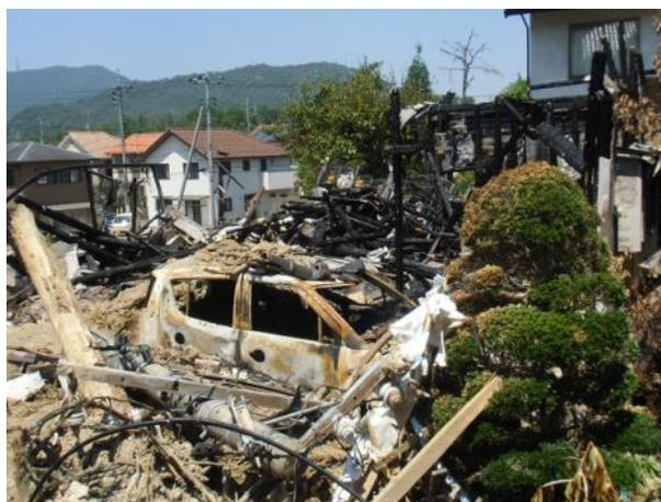
切れた電線からの漏電により焼失した家屋
