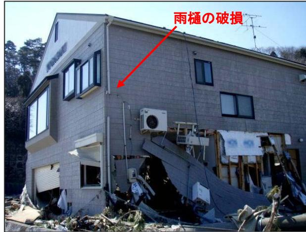
写真 37 津波の痕跡（家屋の雨樋の破損、図 21 の 39）
