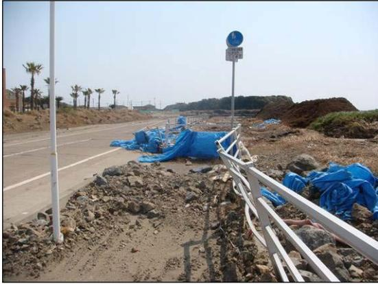
写真 15 千葉科学大学本部正門前の道路ガードレールや標識等が損傷を受け傾いている
