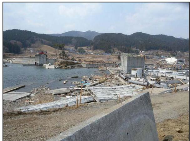
写真 12 津波により破壊された岸壁
