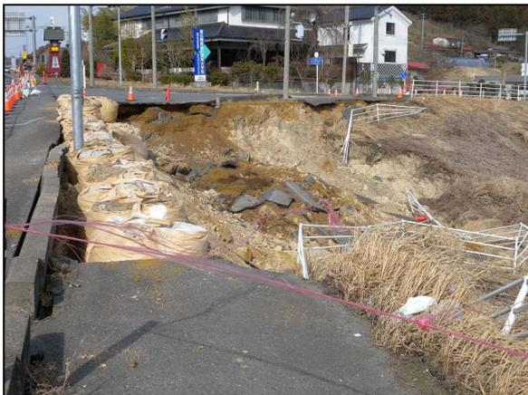
写真 11 栗原市築館国道 4 号線沿いの崖崩れ
