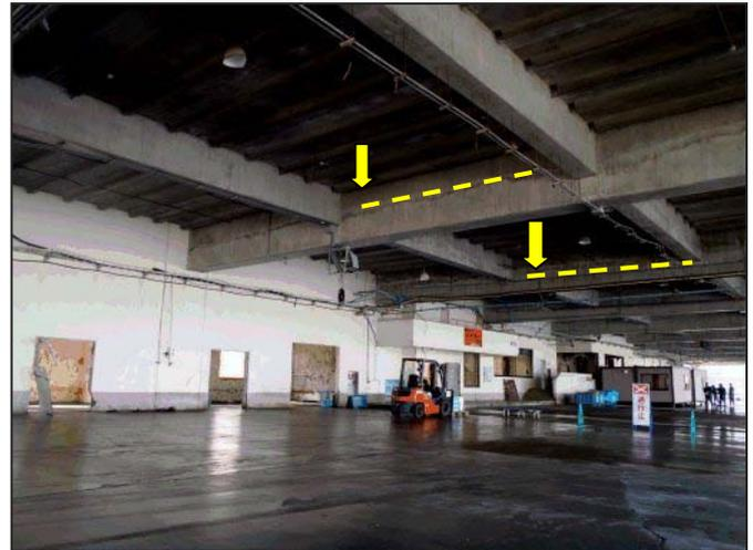
写真 2 津波の痕跡（魚市場内側の柱に痕跡、図 5 の 22）
