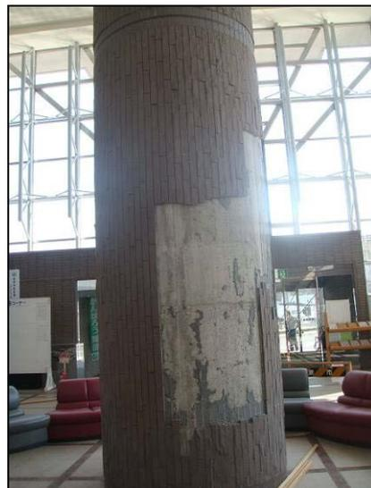
写真 12 栗原市役所の柱タイルの剥離
