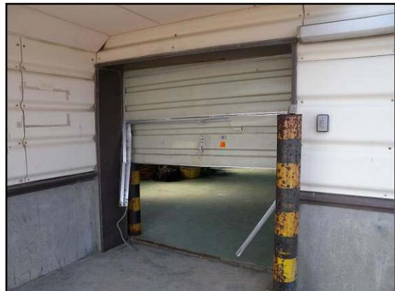
写真 9 倉庫のシャッターが損壊
