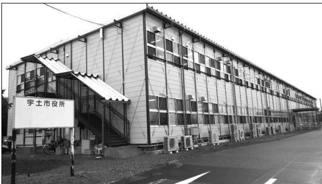
写真 7 宇土市仮設庁舎の外観（平成 28 年 12 月 13 日撮影）
