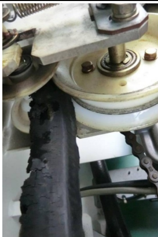
ユニット内ホース状況
