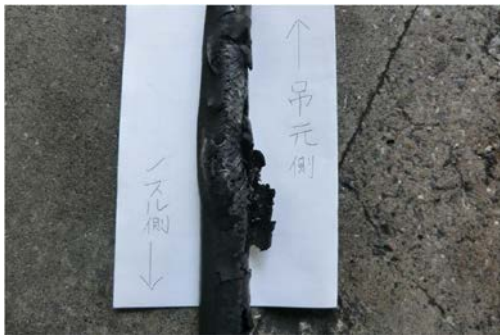
給油ホースの破損状況
