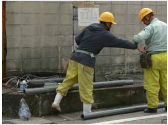
下水道仮復旧 2
