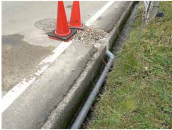
下水道仮復旧 1
