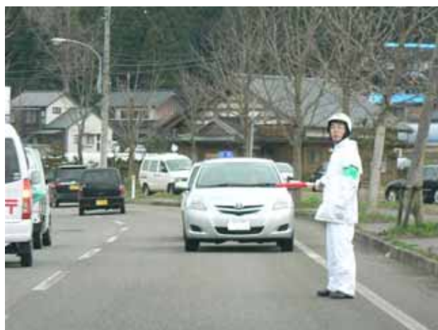
幹線道路の復旧工事による交通規制 2
