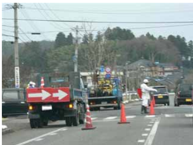
幹線道路の復旧工事による交通規制 1
