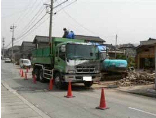
集落の被害状況 1
