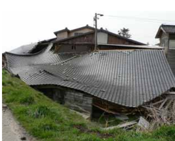
道下地区材木工場被害状況
