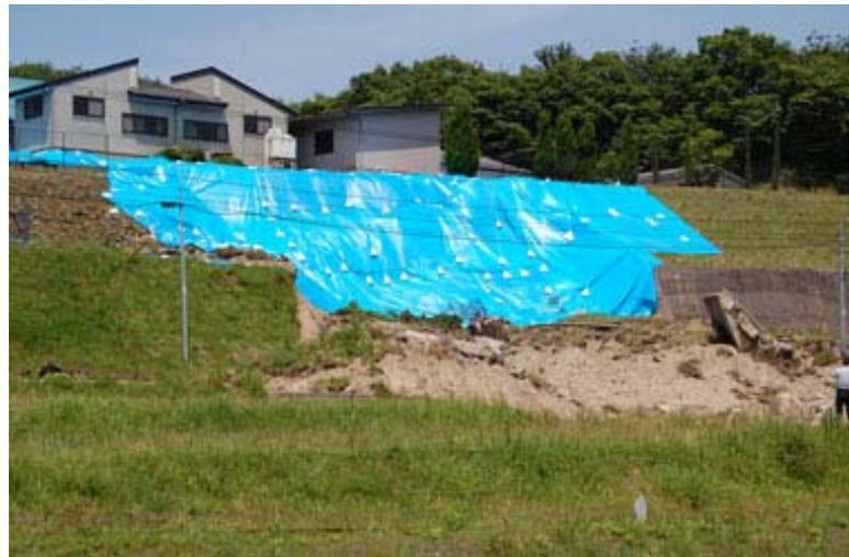
よう壁を押し出すように崩れている。手前の道路は土砂に埋まっている。
