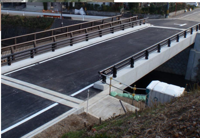
写真 10.6.2 復旧した同三河橋
