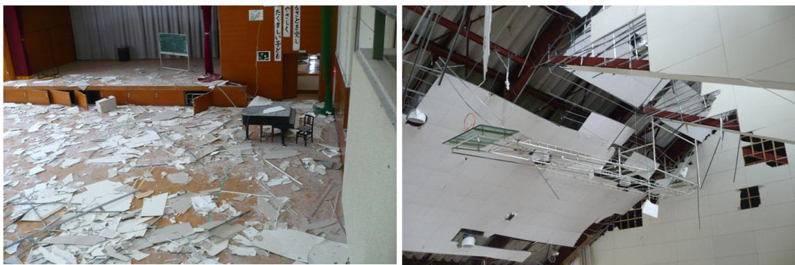
写真 3-4 東部小学校（平成 23 年 3 月閉鎖）体育館の被害の様子
