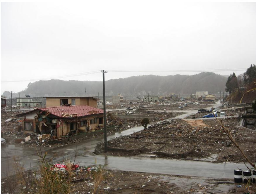
写真 2-2 田老地区市街地の被害（震災から約 1 ヶ月後）
