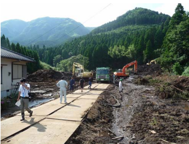
捜索活動現場の様子(重機搬入のための敷き鉄板)
