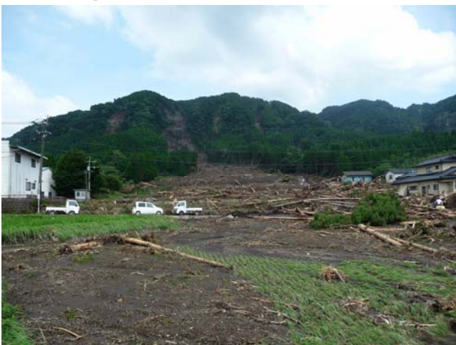
崖崩れの様子(下からの全景)
