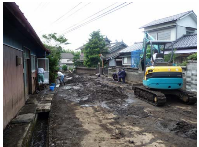
土砂を取り除く作業を行う住民や消防団員
