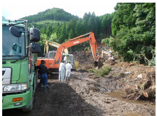
捜索活動の様子を見守る建設作業員
