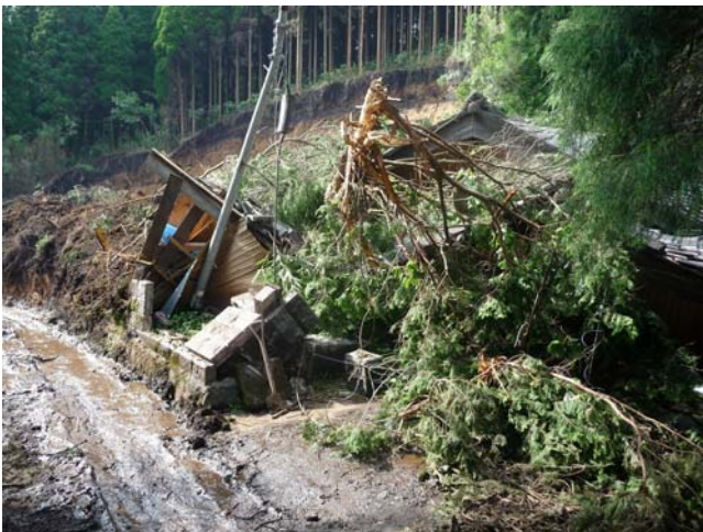
崖崩れにより被害を受けた住家の様子
