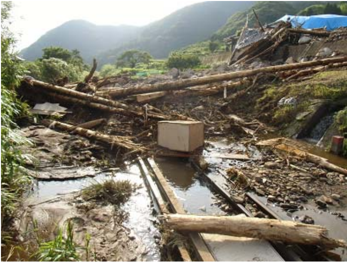
土砂崩れで塞がった線路(豊肥本線)
