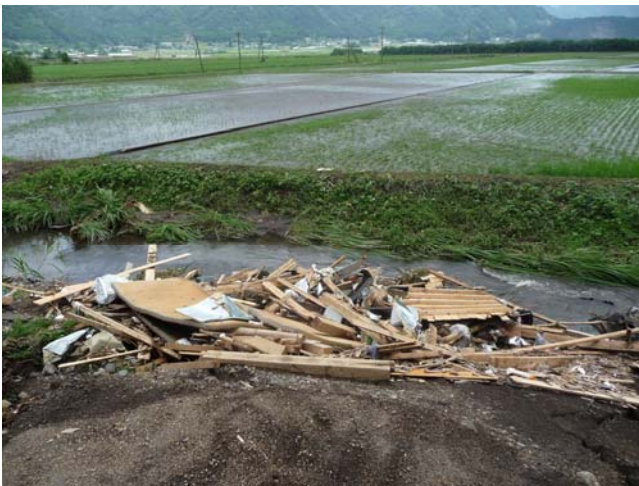
水路に散乱した瓦礫と田んぼに堆積した泥土
