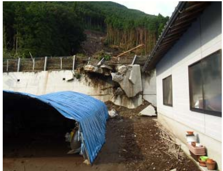
土砂崩れの防止柵により住家倒壊せず
