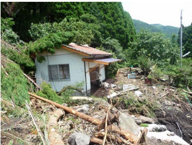
崖崩れにより被災した住家
