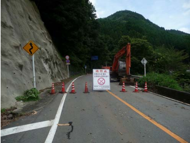
崖崩れによる県道 11 号線の通行止め箇所
