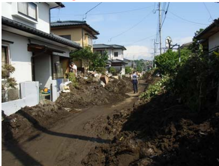
泥に覆われた道路
