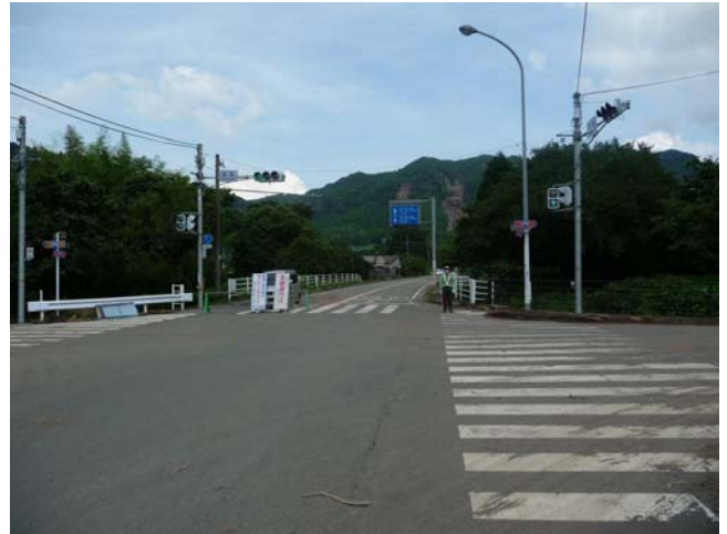
国道 57 号線の坂梨交差点の通行止め箇所
