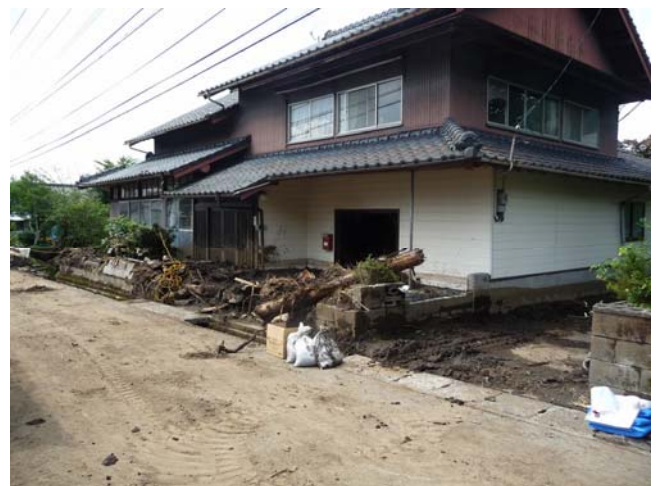
土砂が堆積した住家の様子
