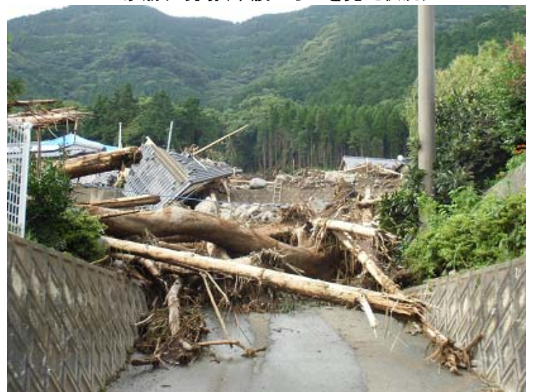
土砂崩れ現場(下から見た状況)
