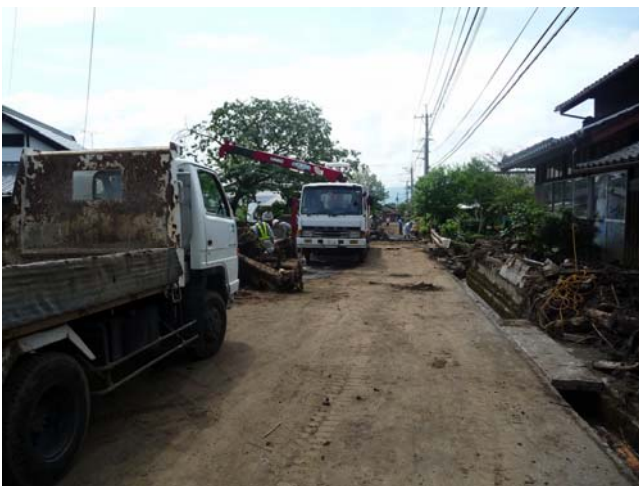
土砂運搬用のトラックとクレーン作業中のトラック
