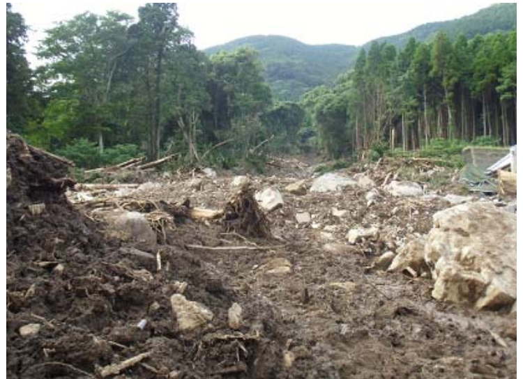
土砂崩れ現場(中腹から上を見た状況)
