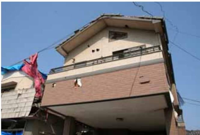
飛散物による家屋の被害
