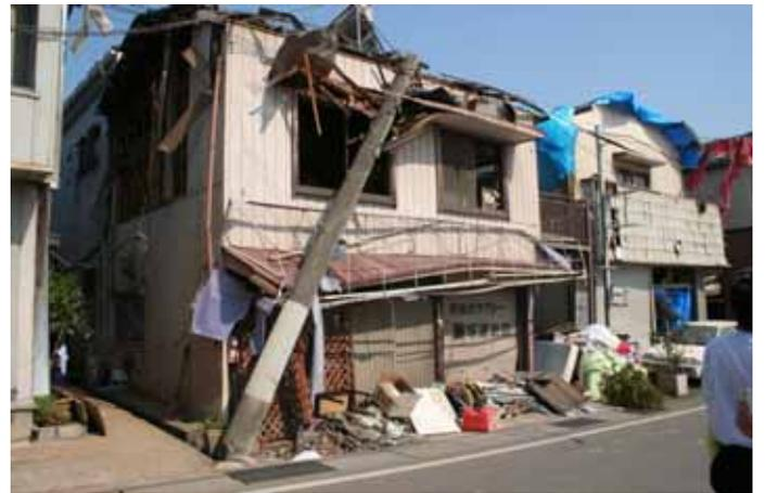
倒壊電柱に直撃された家屋
