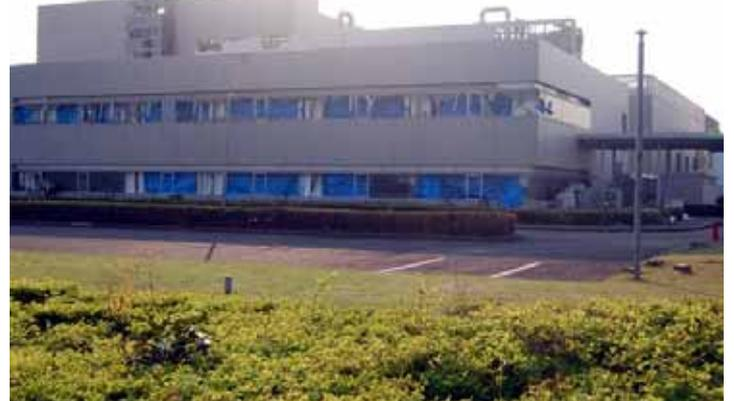
竜巻に伴う突風等で、窓ガラスが割れるなどの被害に遭った工業団地内施設。
