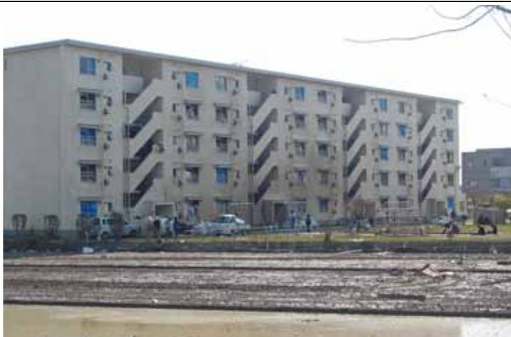
被害の大きかった南棟の北面を望む。南面よりも被害は少ないが、ほとんどの窓ガラスが割れ、下には竜巻に飛ばされた車両が横倒しになっていた。
