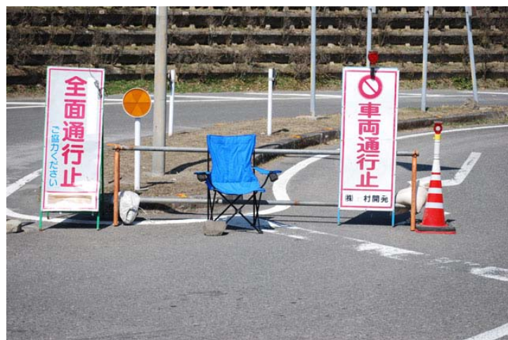
全面通行止となった国道 223 号線
