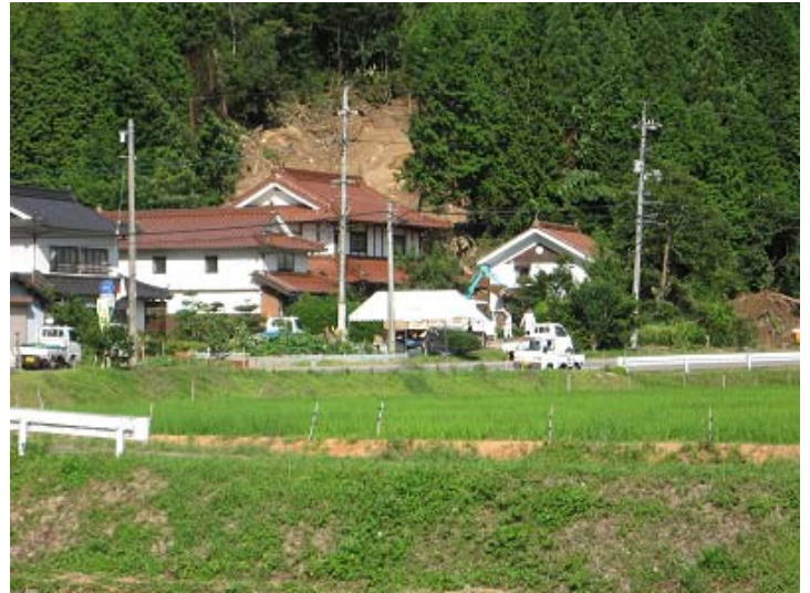
土砂災害現場
