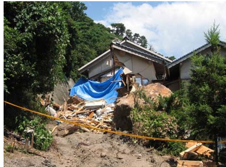
大きな岩の落下により倒壊した住宅
