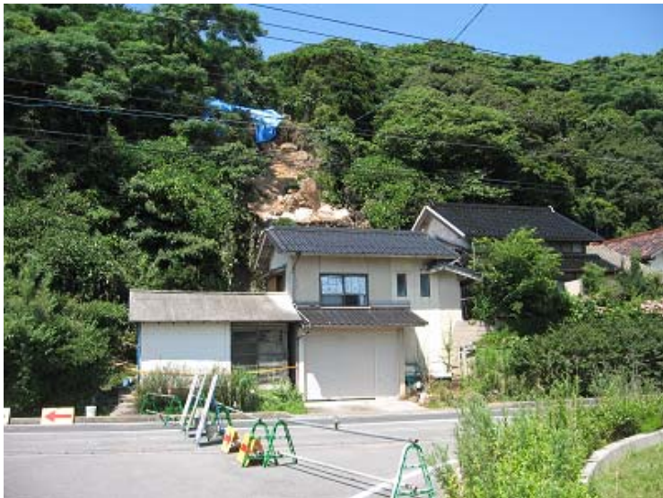
土砂災害現場(鹿島町内)
