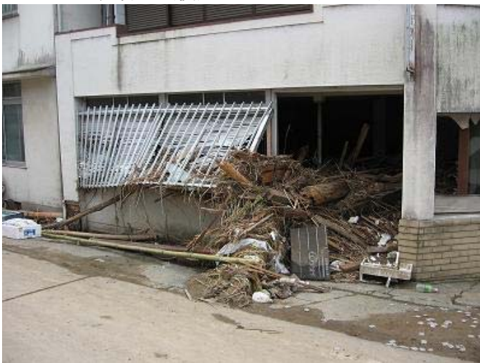
民家内の被災状況
