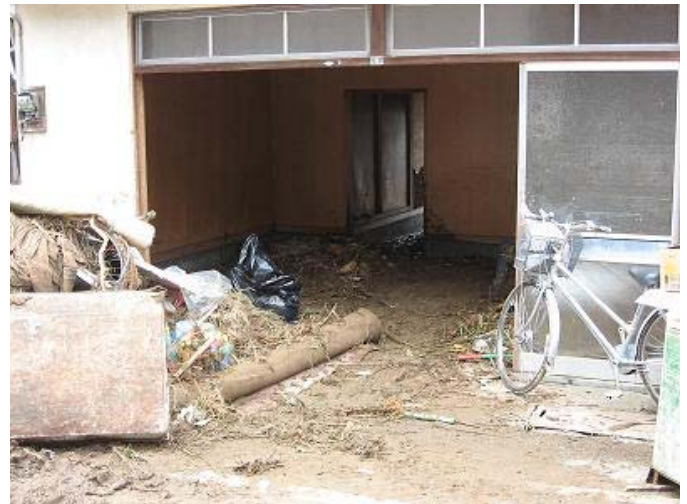
民家内の被災状況
