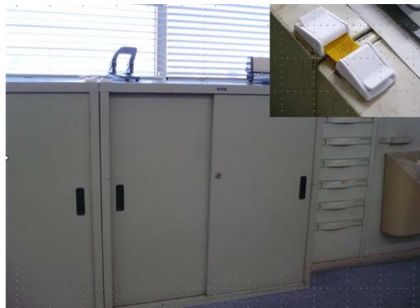
固定されたキャビネット (牧之原市相良庁舎)
