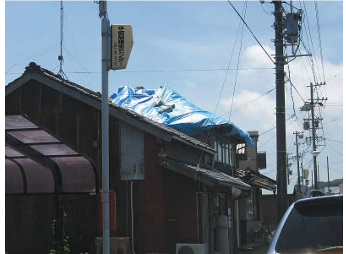
ブルーシートによる補修(旧相良町内)
