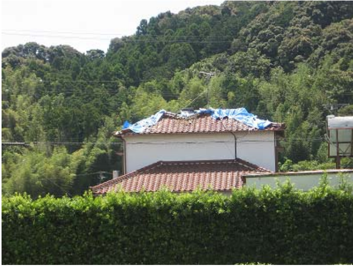
ブルーシートによる補修(旧榛原町内)
