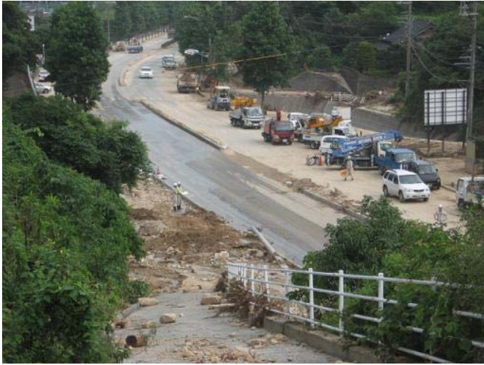
土砂崩れ現場から市街地方面に土石流が流れた跡 (国道 262 号線沿いを流れる)
