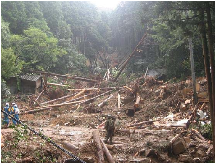
搜索現場上の土砂が崩れた場所 (右上写真の右上奥)
