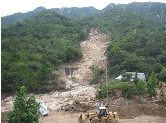
土砂崩れ現場(中央付近は砂防ダム)
