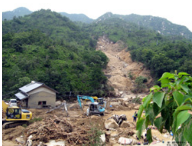
土砂災害発生現場
