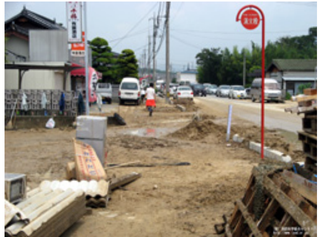
道路に流出した土砂
