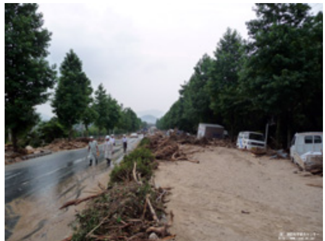
土砂で塞がれた道路
