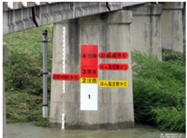
橋脚の水位表示
