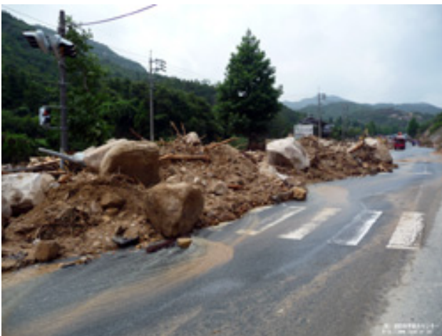
土砂で塞がれた道路
