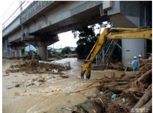
復旧作業の様子
