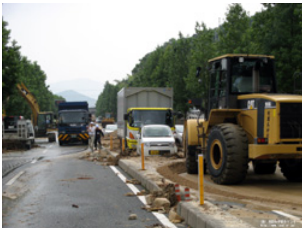
復旧作業の様子
