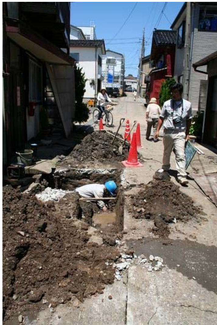
水道の復旧作業
