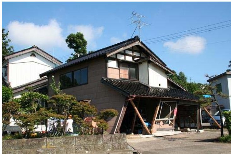
被災した家屋の様子（柏崎市西山町付近）
