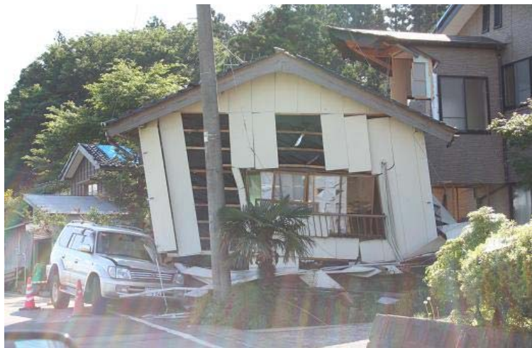
被災した家屋の様子。作業は進められているが、まだ各所にこうした家屋が見られた。（柏崎市西山町付近）
