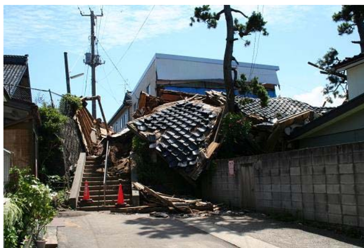
被災した家屋の様子（柏崎市東本町付近）
