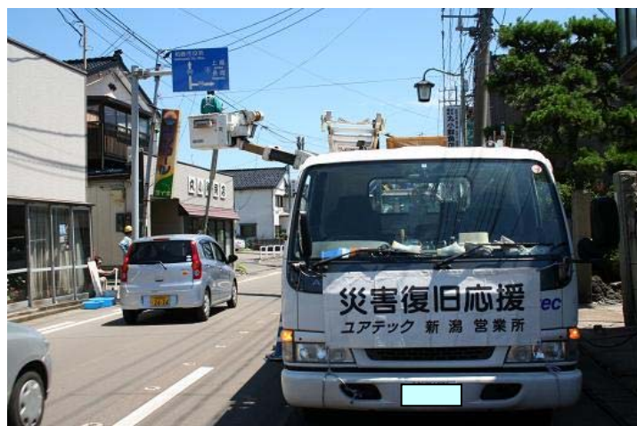
電力復旧作業中
