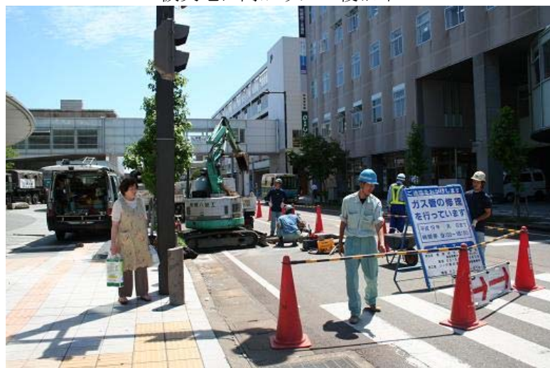
ガス復旧工事中
