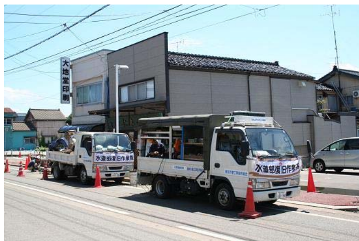
水道復旧工事中
