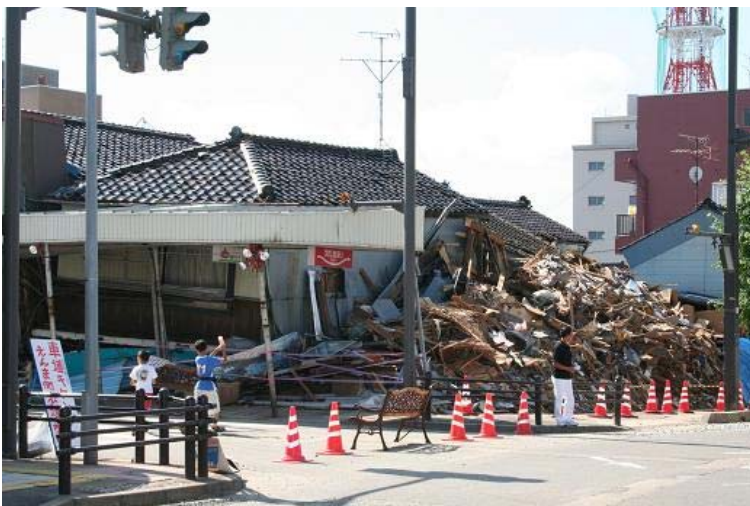
車両の通行できない道路もあった。（柏崎市東本町付近）
