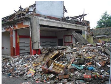
写真 3 6 2 階の住居部分が崩落
