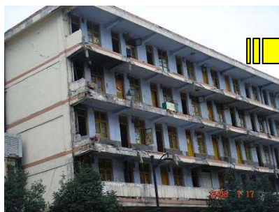
写真 2 3 5 階建ての宿舎の被害状況 (全階ベランダの壁が崩落)
