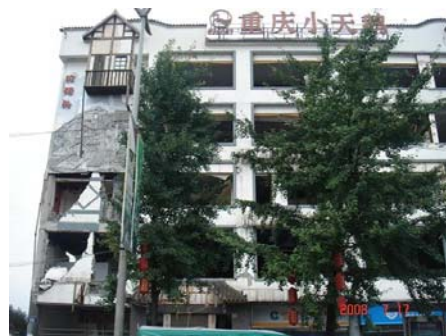
写真19 5階建ての商業ビルと みられる建物(1階部分は使用中)
