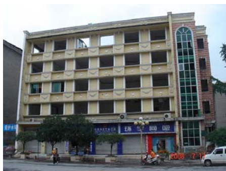
写真 2 1 「都江堰水務」(水処理、河川などの水利事業の管理等を行う行政機関の事務所) の被害状況
