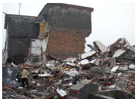
写真7 建物全体が崩落した現場
