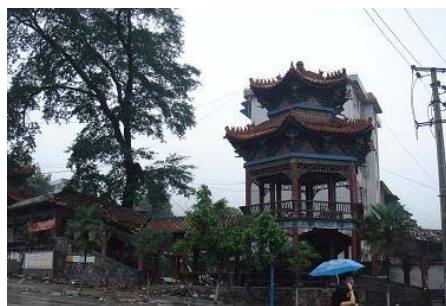
写真9 写真4～8の現場付近にある古建築の様子(軽微な被害)
