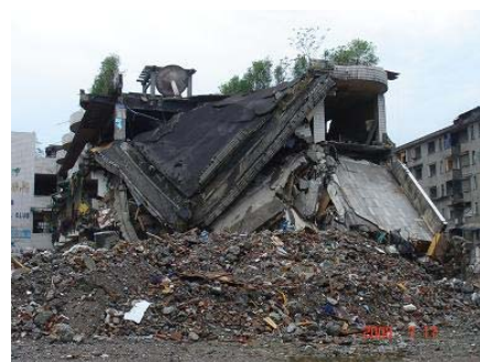
写真20 3階建ての公共施設と みられる建物の崩壊
