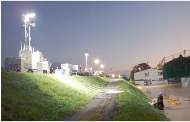
写真5 排水ポンプ車による 24時間体制の緊急排水
