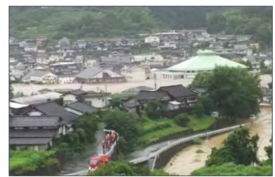
写真 3 肱川の氾濫（その 2）
