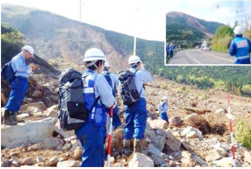
写真3 土砂災害危険箇所の調査
