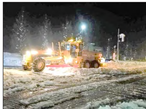
写真10 降雪による通行止め道路の除雪
