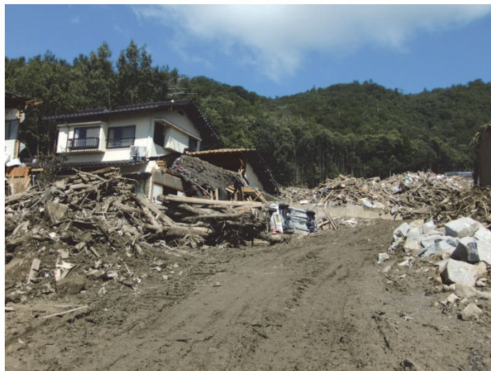
山裾まで住宅地が開発された広島市八木地区の被害
