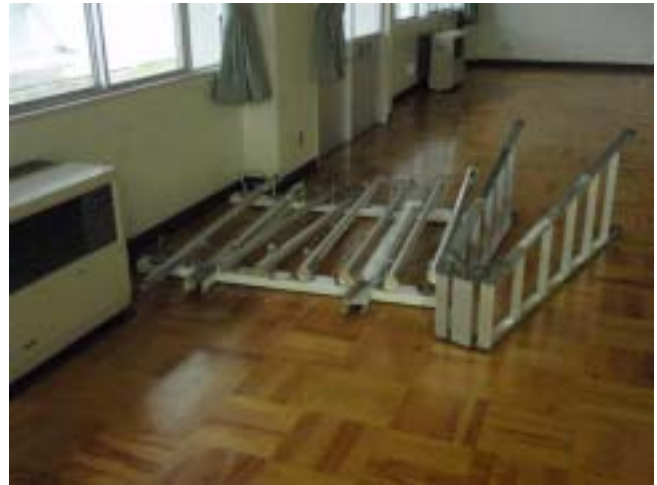
破損した蛍光灯 (洋野町大野小学校)
