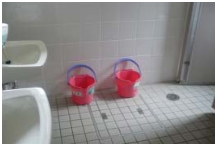
断水のため用意されたトイレを流すためのバケツ (洋野町役場大野庁舎)
