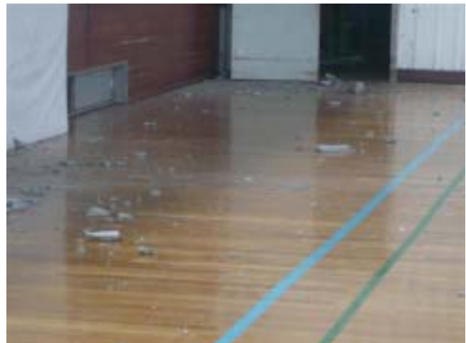
コンクリート片・窓ガラスの破片が散乱した 種市体育館内部
