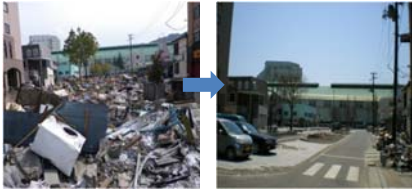
(釜石市内のがれきの撤去状況)
