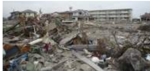
写真 6.3.11-17 津波作用方向から見た RC 造集合住宅の反対側で流失を免れた木造家屋群 (⑬)
