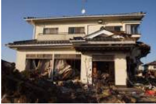
写真 6.3.10-42 残存する木造建物
