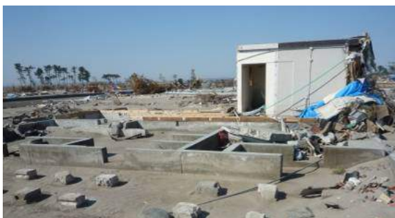
写真 6.3.10-7 土台も流失した例
