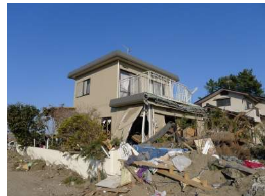
写真 6. 3. 10-26 残存する軽量鉄骨造住宅 (⑫)
