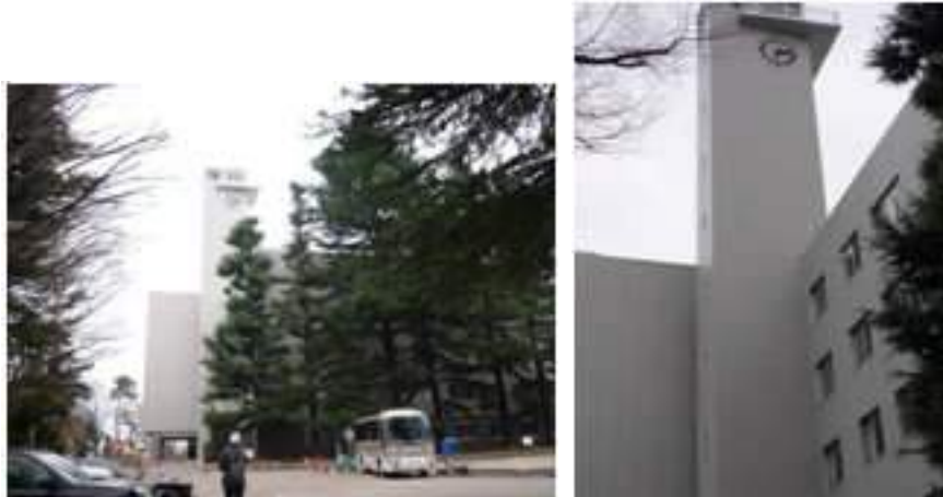
写真 5.4-69 県庁本庁舎及び時計塔の外観
