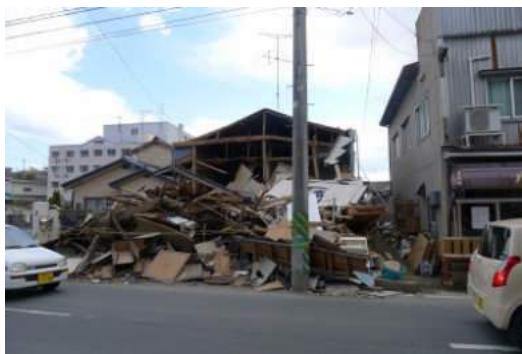
写真 5. 2. 4-3 倒壊した木造住宅
