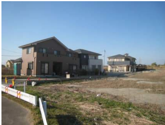
写真 5.5.2.1-47 液状化により傾斜した戸建て住宅群
