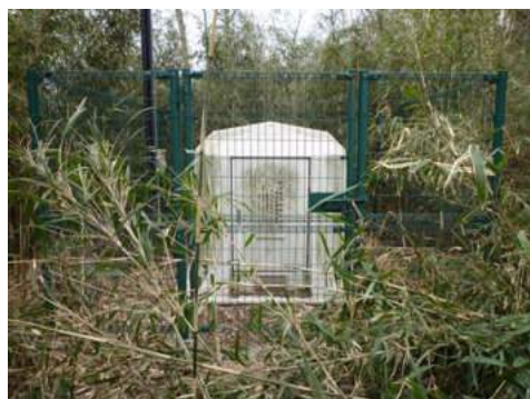
写真 5.2.1-2 K-NET 栗原築館 設置状況（左側に約 3m の段差あり）
