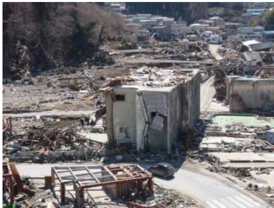
写真1 建物の遠景 (北東側から)
