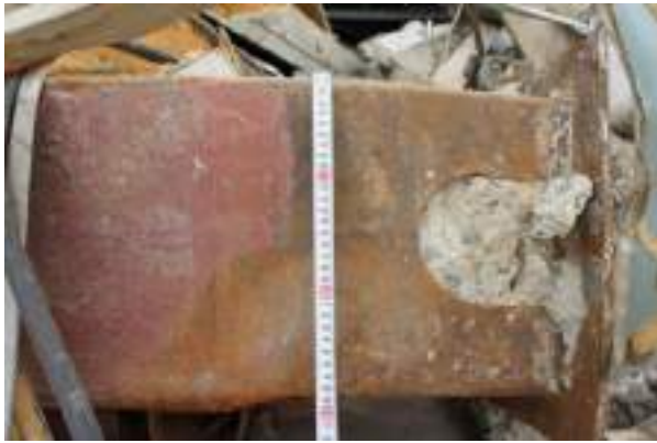
写真 6.3.11-24 写真 6.3.11-23 の露出柱脚
