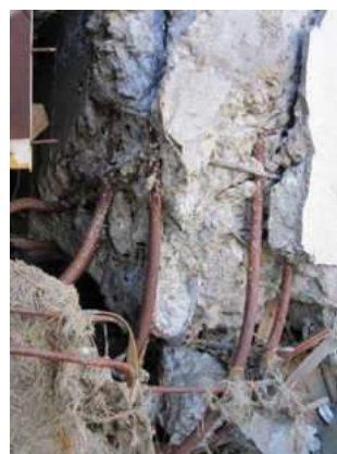
写真 4 1階柱頭の柱主筋
