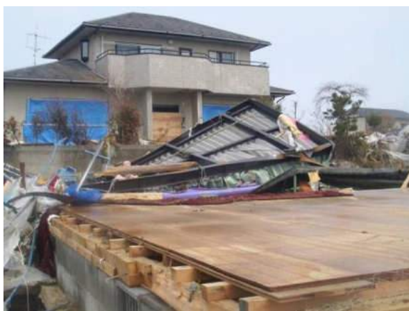
写真3 残存した住宅と上部構造が流失した住宅
