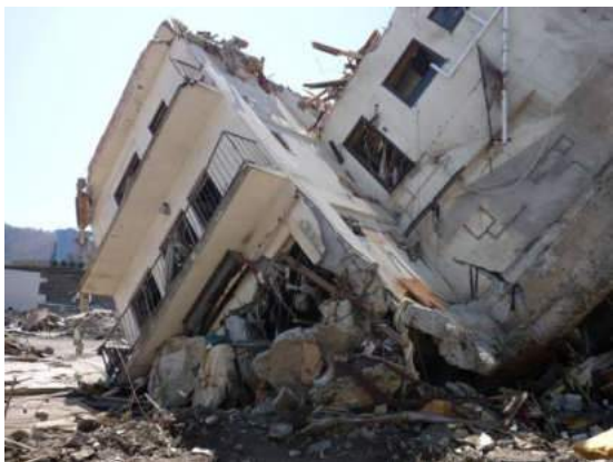
写真4 隣で転倒した建物
