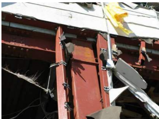
写真3 建物の柱梁部材
