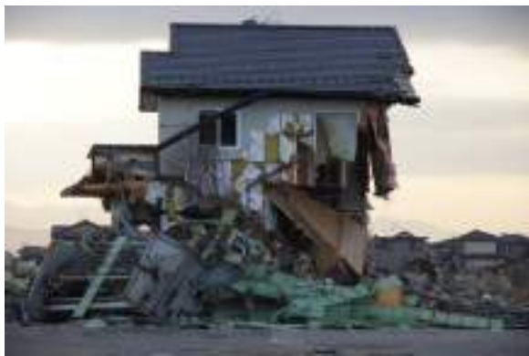
写真6.3.13-3 躯体及び外装材の流失した木造住宅 (①)
