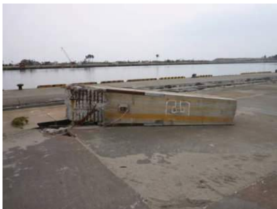
写真3 独立柱 (1本だけ残存、他は流失)
