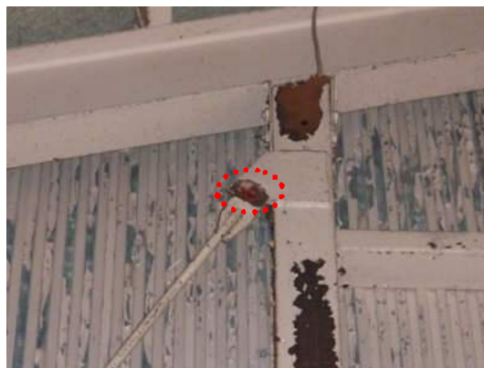
写真 5.3-17 ボルトの破断 (JS0-3)
