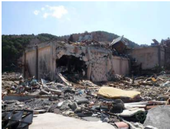
写真1 壁の面外破壊 (建物西面)
