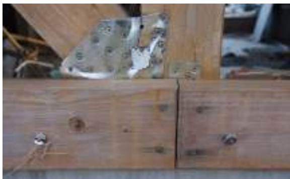
写真 6.3.13-5 写真 6.3.13-4 の接合部金物
