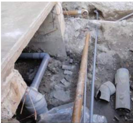
写真 5.5.2.2-17 設備配管の修復状況
