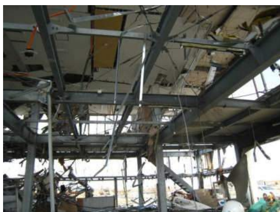
写真4 2階床の流失
