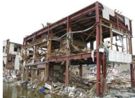
写真 6.5.2-2 残存 S 造骨組み
