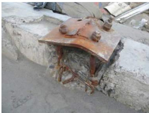
写真 6.4.2-1 柱脚部の破断(陸前高田市) 写真 6.4.2-2 柱脚部アンカーボルトの破断により移動したと考えられる建築物(釜石市)
