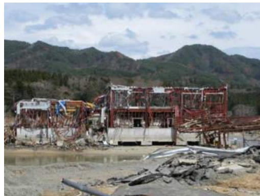
写真 6.4.2-21 残存するS造（山田町船越） （洗掘を受けて基礎が見える。）
