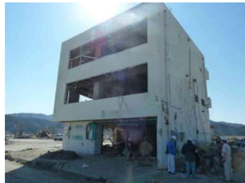
写真 6.4.1-2 残存する3階建て建築物
