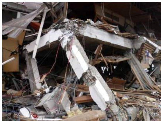
写真3 1階 RC 造架構
