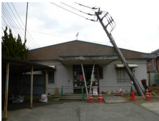
写真 5.5.2.1-3 保健センター入口付近の状況
