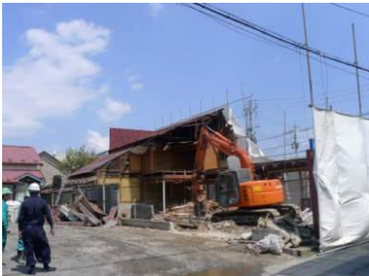
写真 5.2.2-33 解体工事中の木造住宅
