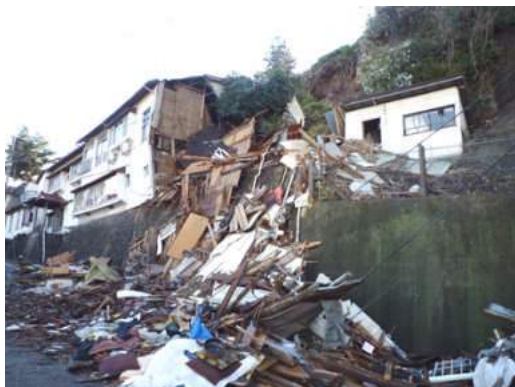
写真 5.2.5-12 旅館の倒壊現場 (仙台市太白区向山)
