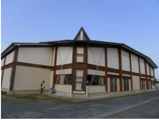
写真 5.2.10-7 集成材構造の木造体育館
