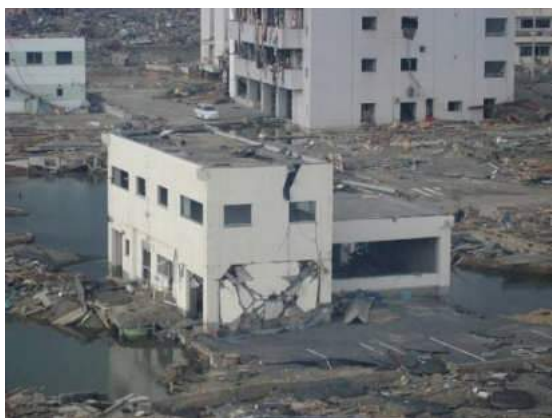
写真1 建築物の外観
