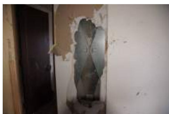
写真 6. 3. 13-12 写真 6. 3. 13-11 の室内の状況
