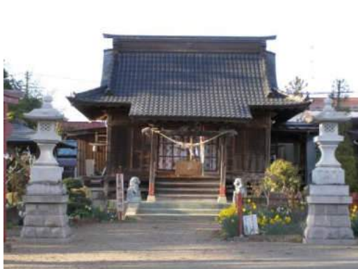
写真 5.2.3-9 残留変形が認められる神社
