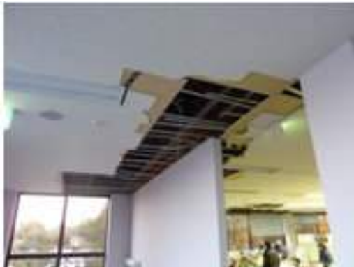
写真 5.4-192 付近の建築物の天井被害 1 写真 5.4-193 付近の建築物の天井被害 2
