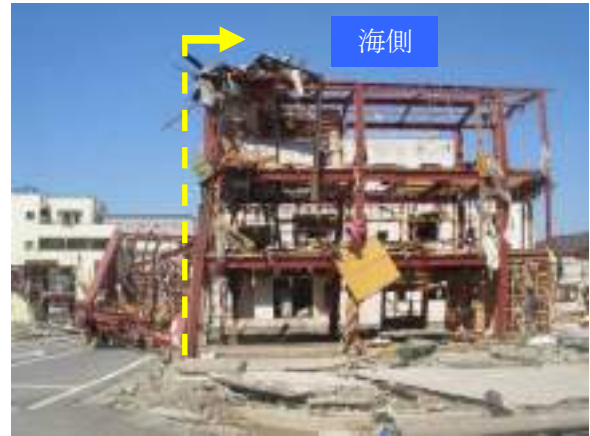
写真 6. 2. 1-5 引き波の作用によると思われる海側への傾斜
