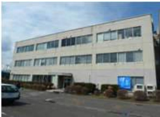
写真 5.4-57 建築物外観 (写真右端で隣棟と接続)
