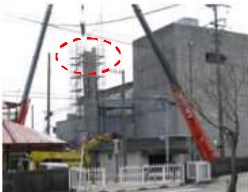
写真 5.4-155 亀裂の入った煙突の上部を解体中
