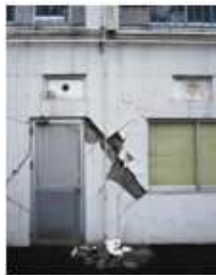
写真 5.4-48 せん断破壊
