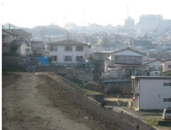
写真 5.5.2.3-9 宅地盛土の滑动・地盤変状により被災した住宅群（青山2丁目付近）
