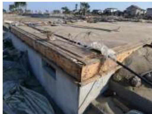
写真 6. 3. 10-22 流失した2×4工法住宅
