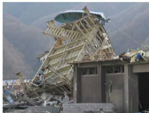
写真 6.4.2-1 柱脚部の破断(陸前高田市) 写真 6.4.2-2 柱脚部アンカーボルトの破断により移動したと考えられる建築物(釜石市)
