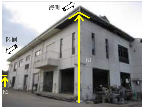
写真 6. 2. 1-7 同一の建築物のなかで浸水深が異なる場合の例
