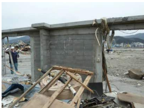
写真4 ブロック壁を挟むRC柱
