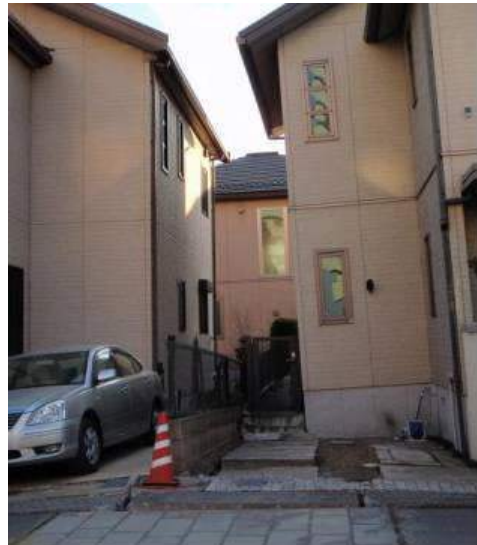
写真 5.5.2.2-18 傾斜した住宅
