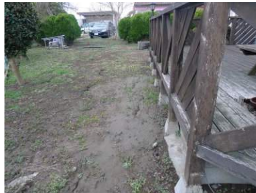
写真 5.2.12-4 液状化による噴砂痕
