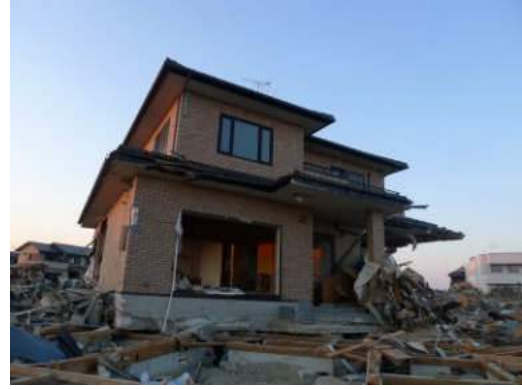
写真 6.4.3-9 べた基礎ごと建設地から移動し残存した例
