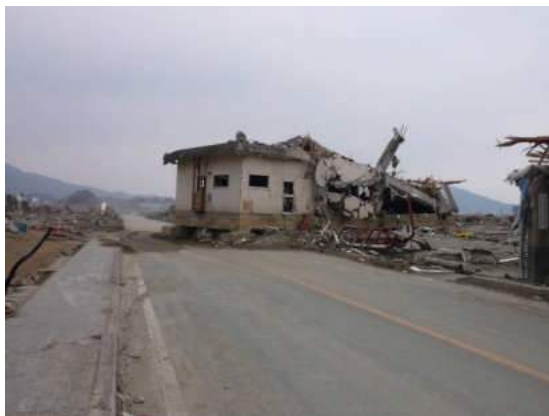
写真1 津波で建物が道路上に移動
