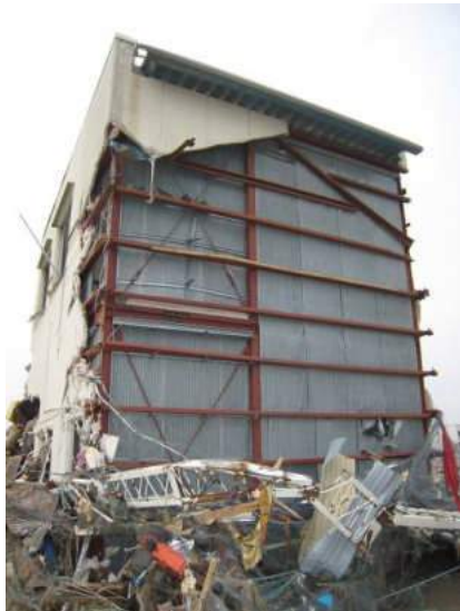
写真3 外壁が流失
