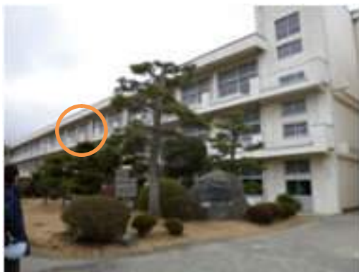
写真 5.4-178 A 中学校の校舎外観
