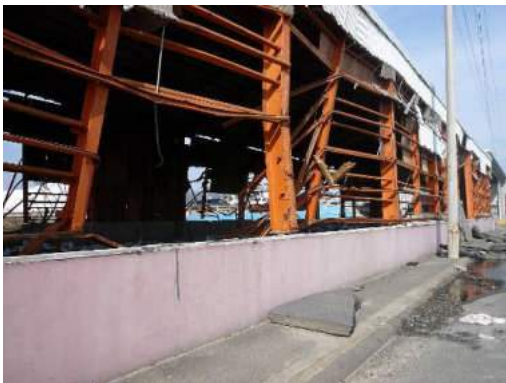
写真 6.4.2-25 柱の変形（石巻市） （コンクリート塊や道路の舗装アスファルト等の漂流物によると考えられる）
