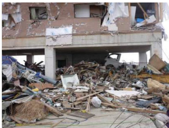
写真4 1階RC造架構は無被害
