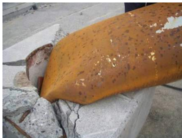
写真2 柱脚部のコンクリートの状況
