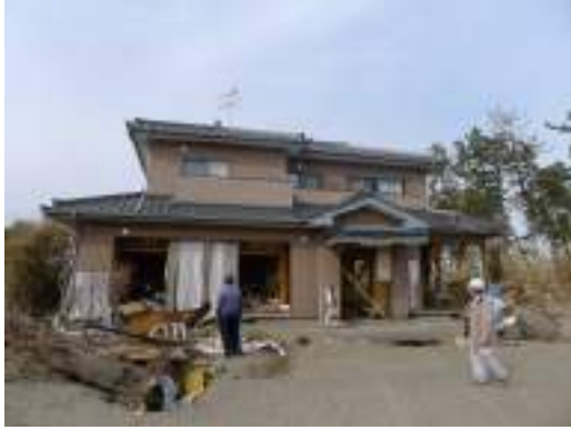
写真 6. 3. 11-52 残存した木造住宅 (①)
