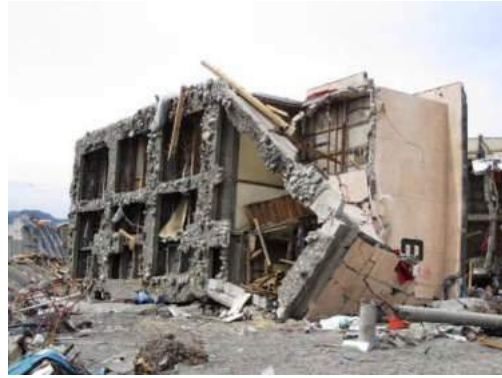
写真 9 移動し転倒した住棟 1
