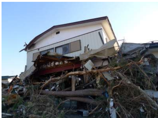
写真 6. 3. 10-34 全壊状態の H 形鋼梁を有する 木造住宅(16)
