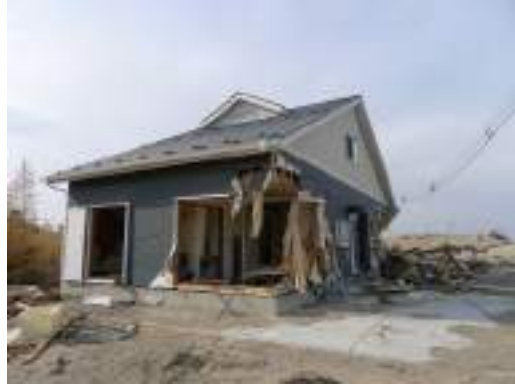
写真 6. 3. 11-59 残存した木造住宅 (⑤)
