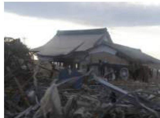
写真 6. 3. 12-8 寺院の被害例 (寺島地区)
