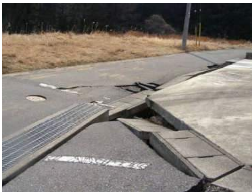
写真 5.2.8-7 路盤の陥没
