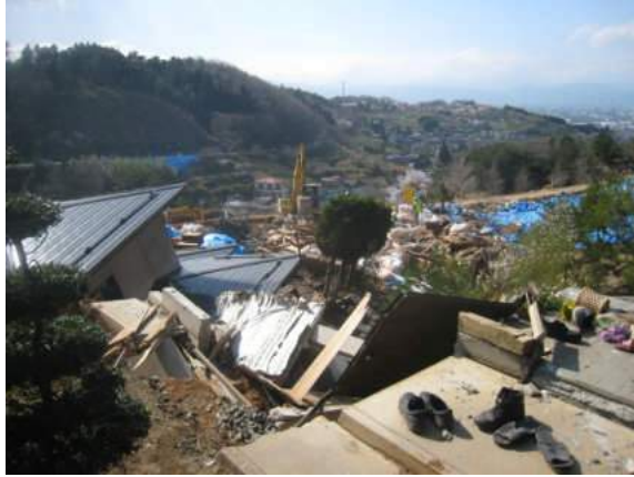
写真 5.5.2.3-47 丘陵の西側の斜面地②の大規模地すべりの全景
