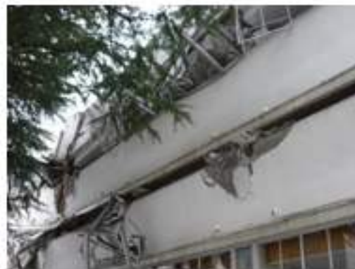
写真 5.4-78 2階層崩壊部
