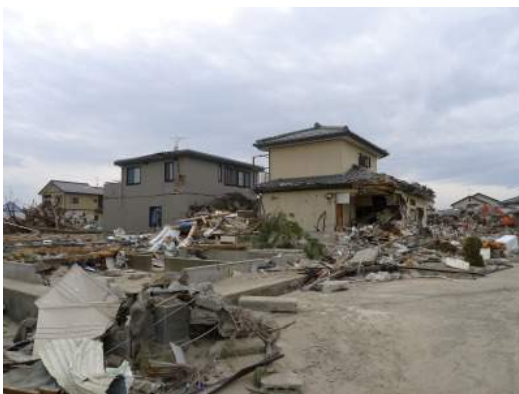
写真 6. 3. 13-27 残存する木造と鉄骨造住宅 (19)
