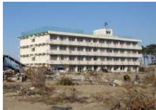
写真 6. 3. 10-14 荒浜小学校校舎外観 (⑥)
