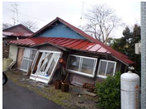
写真 5.2.1-4 地盤変状によると見られる被害
