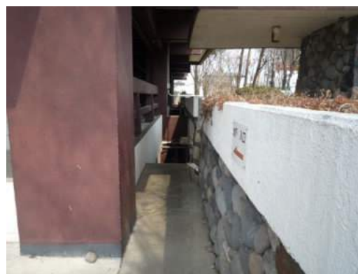
写真 5.2.8-2 震度計の裏のドライエリア
