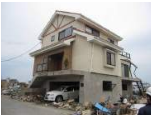
写真 6.3.13-31 建物外観 (㉓)
