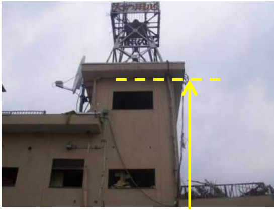
写真4 隣接する消防署の浸水深の推定 写真5 隣接する消防署の開口部の被害状況
