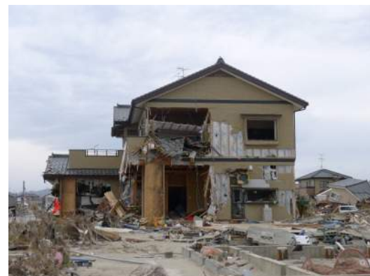
写真 6. 3. 13-28 残存する木造住宅 (20)
