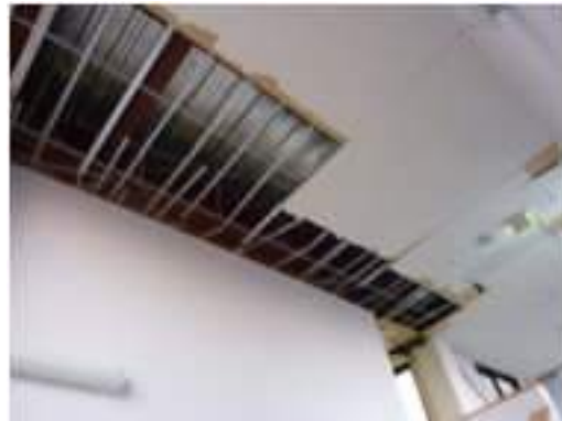
写真 5.4-192 付近の建築物の天井被害 1 写真 5.4-193 付近の建築物の天井被害 2
