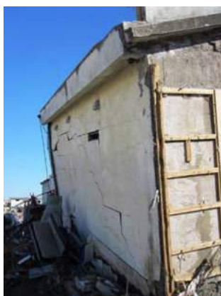
写真 3 コンクリートブロック壁
