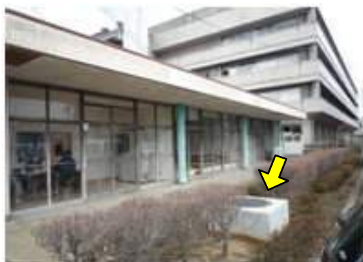
写真 5.4-118 震度計の設置状況
