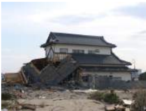
写真 6. 3. 11-62 残存した木造住宅 (⑧)
