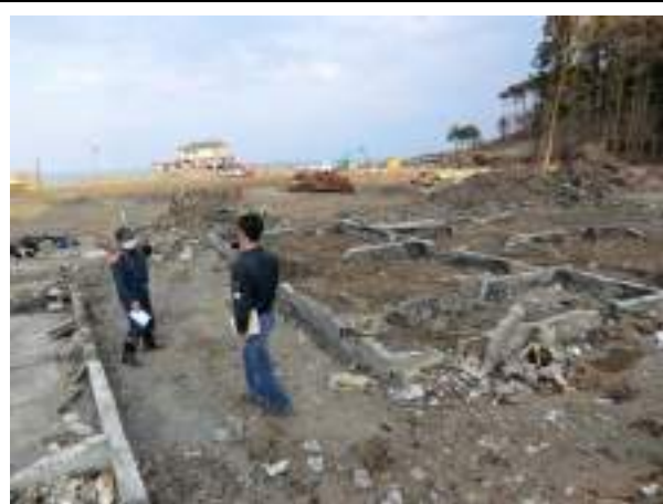
写真 7.3.8-1 火災現場付近
