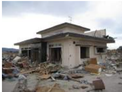
写真 6. 3. 14-8 建物外観 (①)
