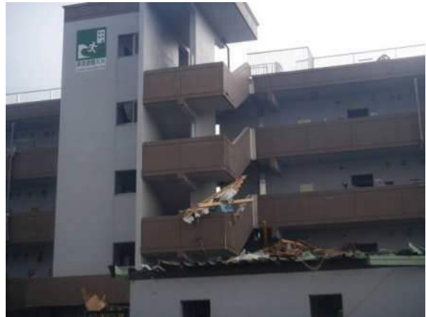
写真2 建築物の外観
