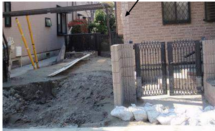
写真 5.5.2.2-6 沈下・傾斜した住宅と噴砂状況 (写真 5.5.2.2-5 の道路を挟んで向かい側の住宅)
