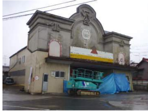
写真 5.2.1-10 古い映画館を改装した工場
