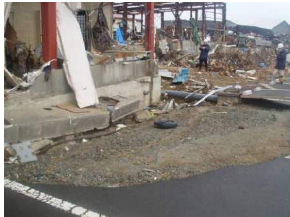
写真4 地盤の洗掘
