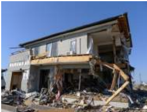
写真 6. 3. 10-21 残存した木造住宅 (⑨)
