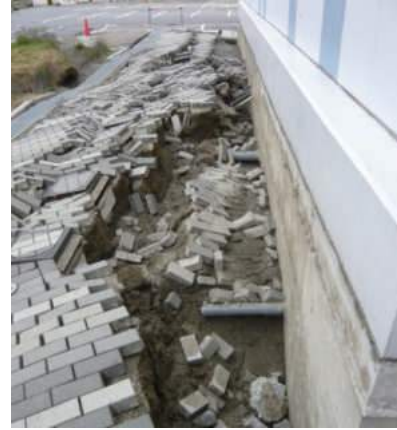
写真 5.5.2.1-21 建築物周囲地盤の状況
