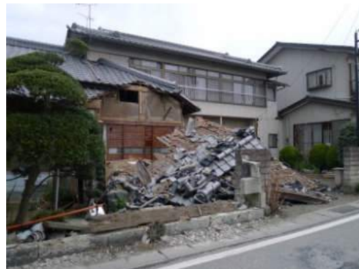
写真 5.2.9-2 住宅の玄関部分の崩壊
