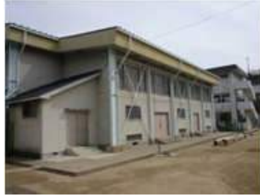
写真 5.4-85 屋内運動場外観
