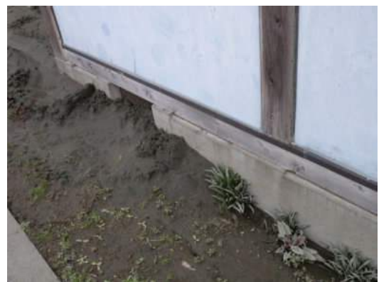
写真 5.5.2.1-32 基礎部分の外観（2）
