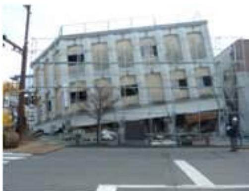
写真 5.4-131 1階の層崩壊
