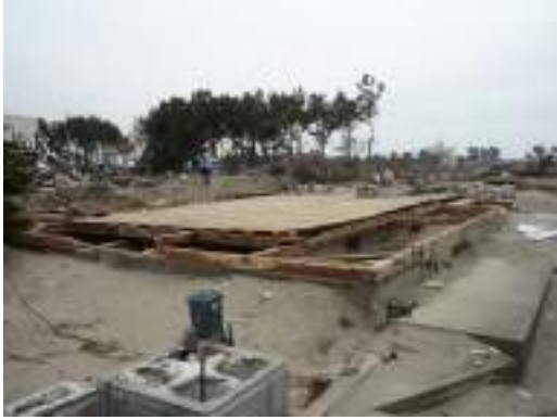
写真 6.3.11-7 なぎ倒された保安林と流失家屋の基礎、土台および1階床 (⑥)
