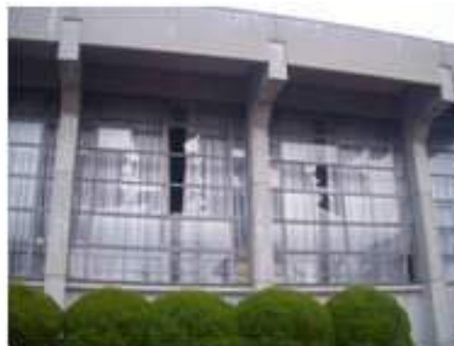
写真 5.4-100 大体育館のガラス破損状況 写真 5.4-101 小体育館のガラス破損状況
