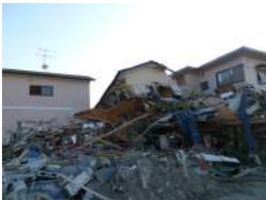
写真 6. 3. 10-31 損傷の激しい木造
