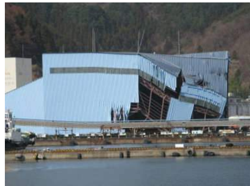
写真 6.4.2-10 2階建てS造の1階の崩壊（大船渡市） 写真 6.4.2-11 部分的な崩壊（釜石市）
