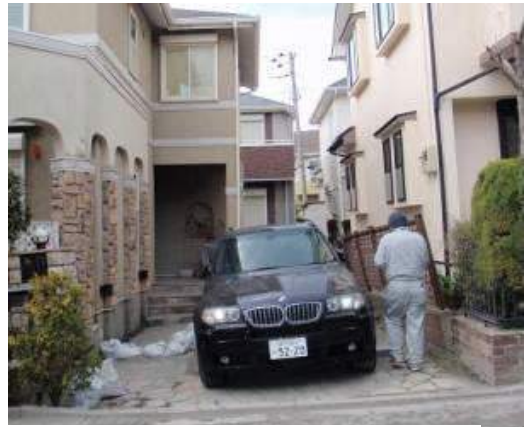
写真 5.5.2.2-10 傾斜した住宅
