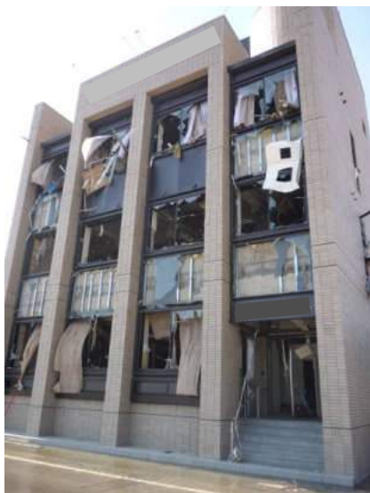
写真 3 建物東面 (海側)
