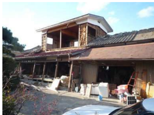
写真 5.2.3-8 1階が大きな残留変形の 住宅
