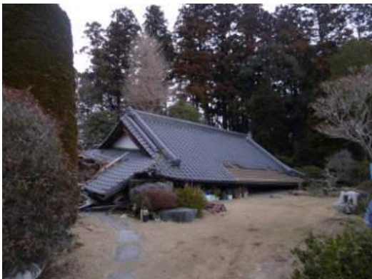
写真 5.2.9-1 1階が完全に崩壊した住宅
