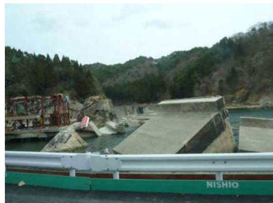
写真4 近傍で決壊した堤防
