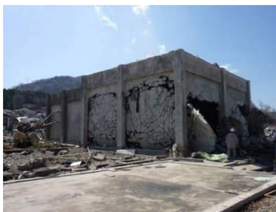
写真2 建物外観(北東側)
