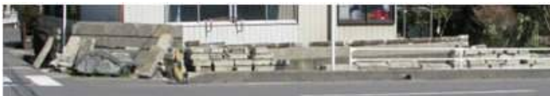
写真 5.4-177 石塀の倒壊
