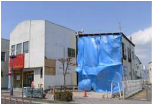
写真 5.2.2-32 取り壊された店舗併用住宅
