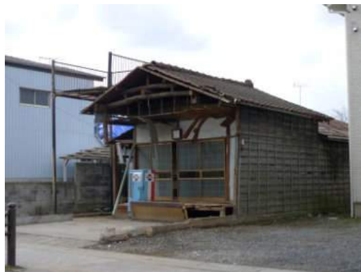
写真 5.2.11-2 損壊部が撤去された住宅 (水戸市本町)
