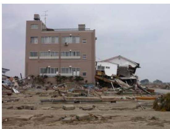
写真1 事務所ビル (背面)
