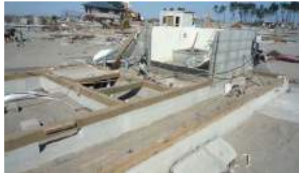
写真 6.3.10-6 残存したCB造の浴室の立上り部分
