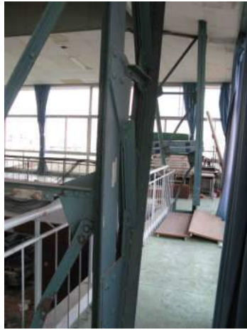
(a) ラチス柱全景
