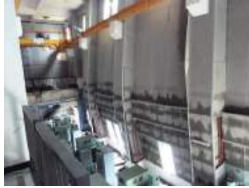
写真 6. 3. 10-45 第3 ポンプ室 内部
