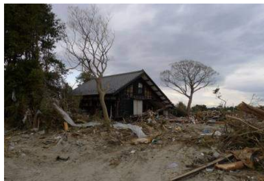
写真 6.3.14-4 残存する木造住宅 (④)
