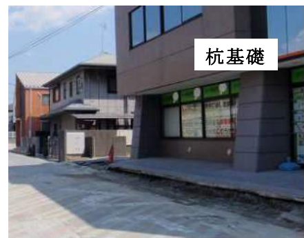
杭基礎建物の側面
