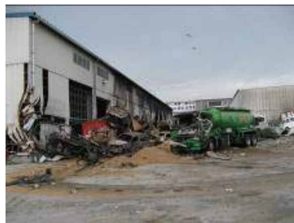
写真 7.3.1-1 仙台塩釜港北側の駐車場1の火災
