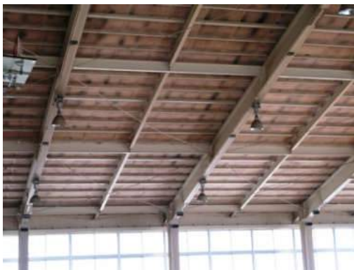
写真 5.3-25 ターンバックルのたわみ (二本松市)
