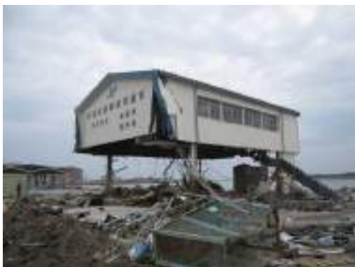
写真 6.3.13-35 建物外観 (㉔)
