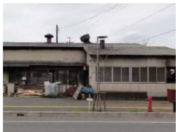
写真 7.3.24 奥州市水沢区羽田町の火災
