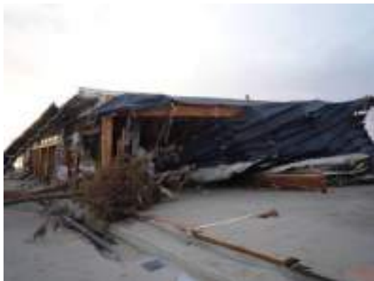
写真 6. 3. 13-9 写真 6. 3. 13-7 の梁間方向 (集成材フレーム構造)
