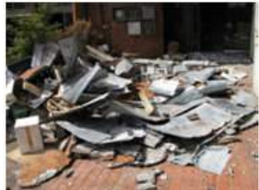
写真 5.4-175 落下した外壁の仕上げ
