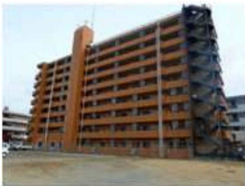
写真 5.4-93 集合住宅Bの外観
