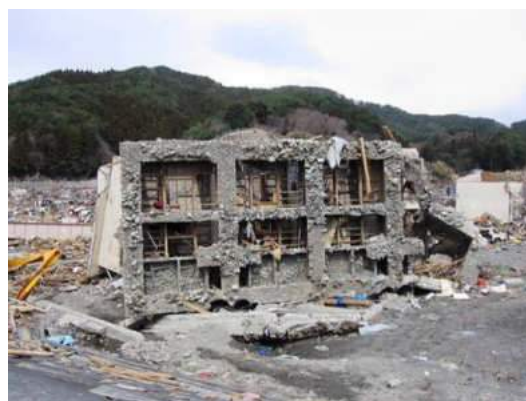
写真3 転倒した基礎断面
