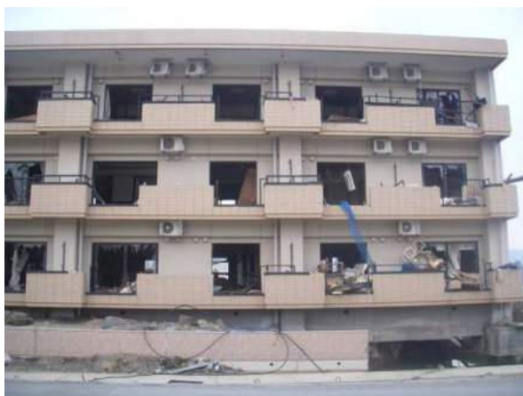
写真1 合同公舎の外観
