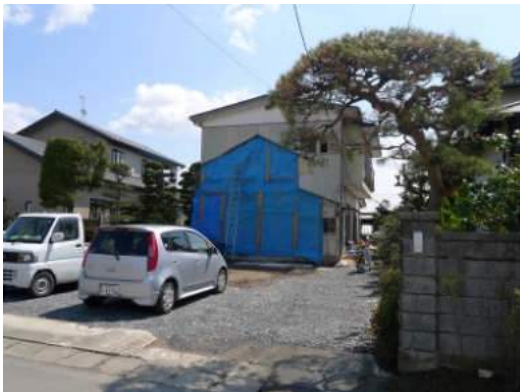
写真 5.2.2-22 前面部分が解体済みの木造
