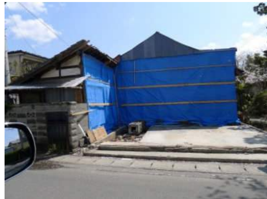
写真 5.2.2-21 前面部分が解体済みの木造
