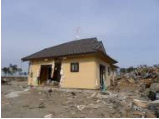
写真 6. 3. 11-58 残存した木造と鉄骨造住宅
