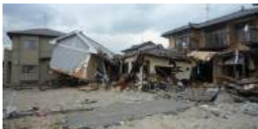
写真 6. 3. 13-19 写真 6. 3. 13-18 の北側で流失した家屋 (㉛)
