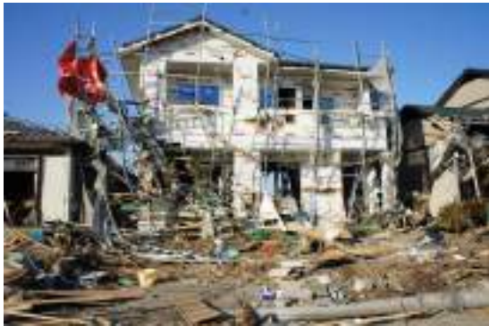
写真 6.3.10-37 建設途中の木造建物
