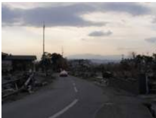
写真 6. 3. 12-5 電柱や塀の倒壊と沿線周辺 (押分、寺島地区)
