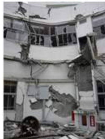
写真 5.4-77 本館中央部 (エキスパンション・ジョイントの 存在は確認できない)
