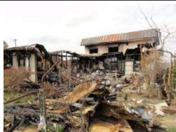
写真 7.3.22 奥州市水沢区小石田の火災
