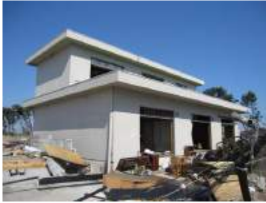
写真 6. 3. 10-9 残存する RC 造住宅 (③)
