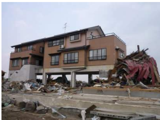
写真1 混合構造建物
