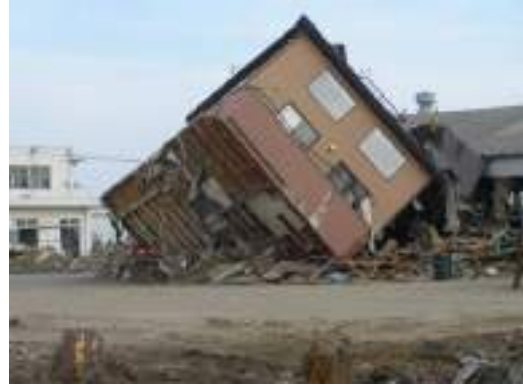
写真 6. 3. 12-2 転倒した住宅 (押分)
