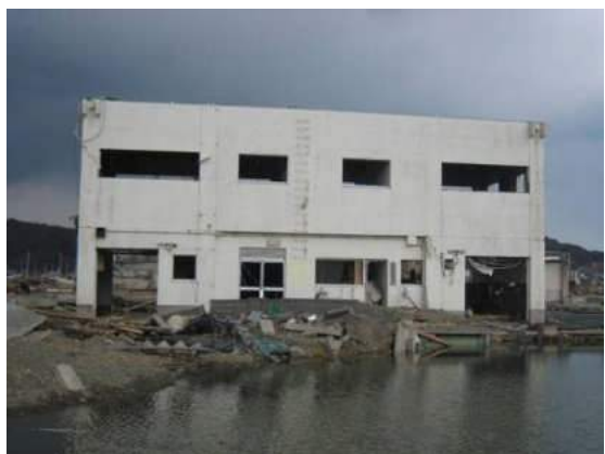
写真2 建築物の外観
