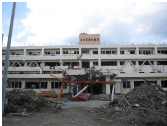
写真4 病院外観 (耐震補強済み)
