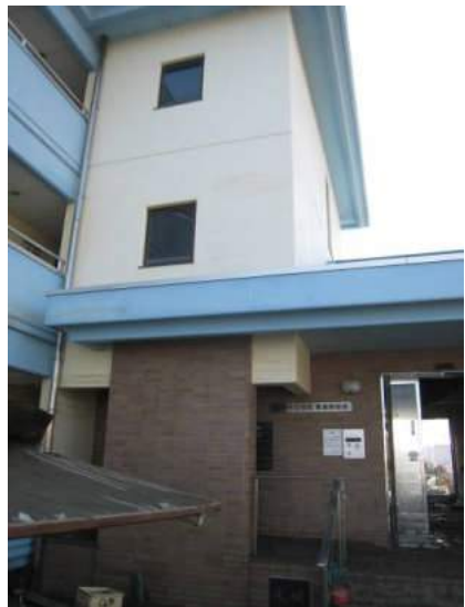
写真2 エントランス部
