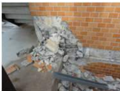
写真 5.4-95 1階柱脚部の破壊状況
