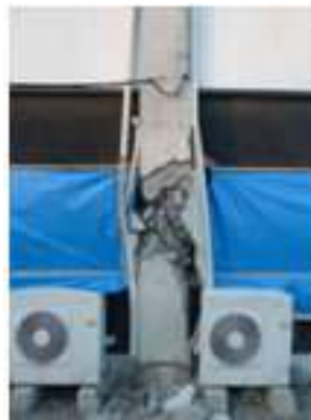
(b) 短柱せん断破壊
