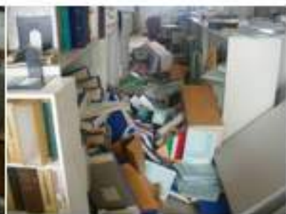
4階（ロッカーの転倒と書類の散乱）
