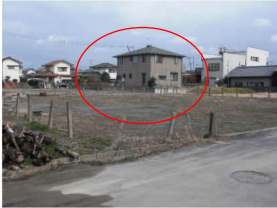
写真 5.5.2.1-33 液状化の発生していない住宅
