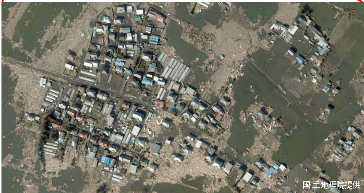
写真 6.4.3-3 最大浸水深が低いため、残存している事例（仙台市若林区荒浜地区）
