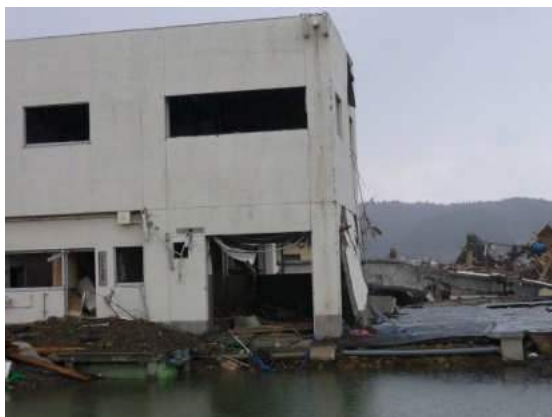
写真3 外壁の面外方向の変形
