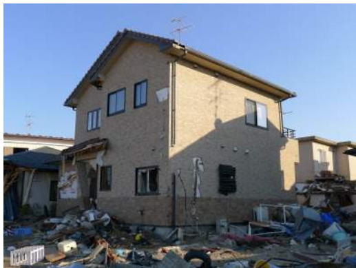
写真 6. 3. 10-32 残存する木造住宅
