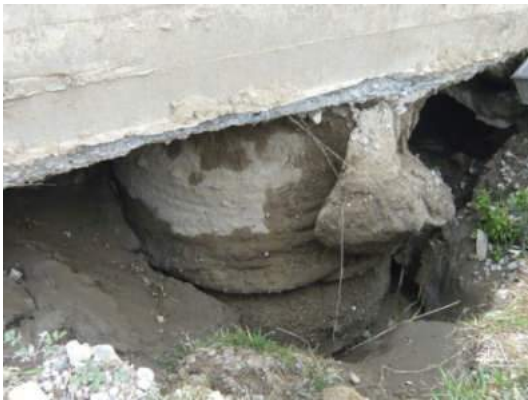
写真 5.5.2.1-22 杭頭部の露出状況
