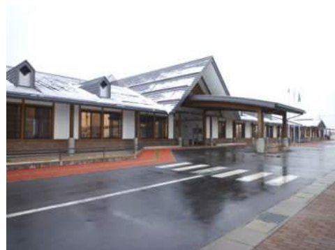
写真 5.2.1-20 木造で無被害の栗駒支所
