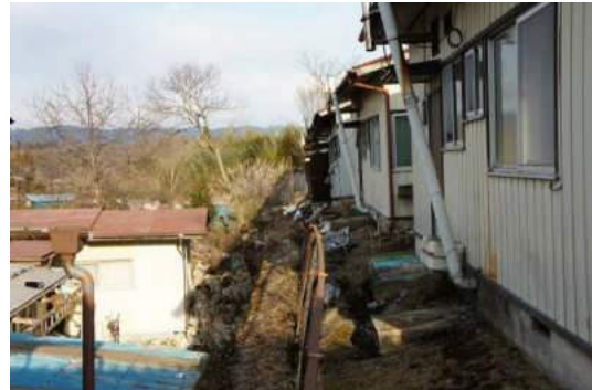
写真 5.2.7-20 写真 5.2.7-19 の立地 (擁壁上部)
