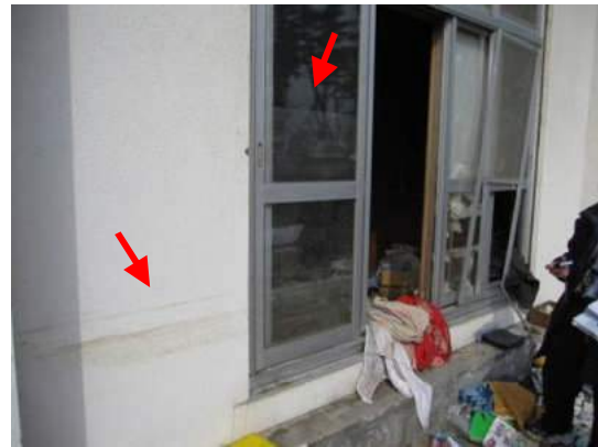
写真2 1階の浸水痕
