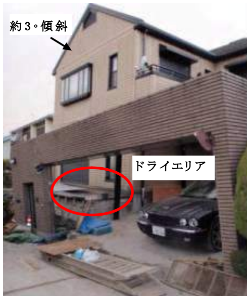
写真 5.5.2.2-1 傾斜した住宅
