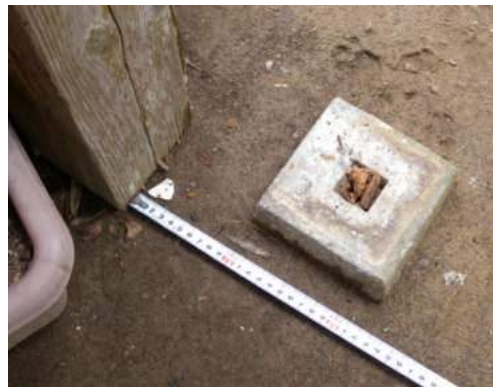
写真 5.5.2.1-10 物置柱脚の移動
