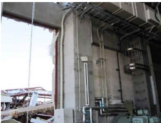
写真 3 架構内部の RC 耐震壁
