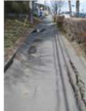
写真 5.4-166 歩道の沈下
