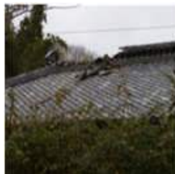
写真 5.4-185 拡大図(写真 5.4-181 の○印内)
