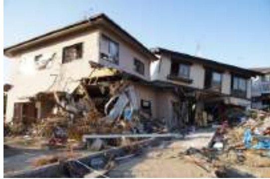
写真 6.3.10-43 残存する木造建物(㊟)
