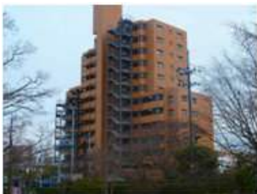
写真 5.4-102 集合住宅Cの外観
