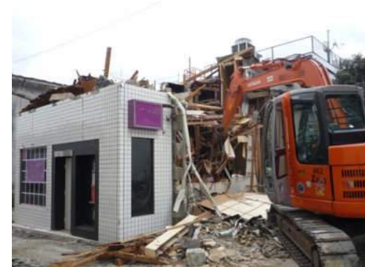
写真 5.2.6-14 写真 5.2.6-13 の解体撤去作業
