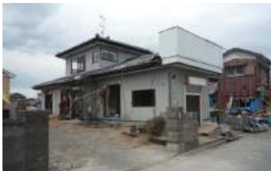
写真 6. 3. 13-17 津波作用方向から見た混構造の反対側で残った店舗併用住宅 (㉙)
