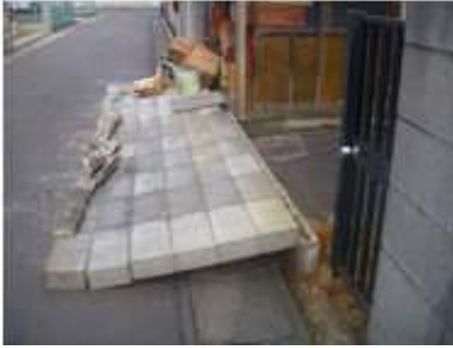
写真 5.4-112 コンクリートブロック塀の転倒 写真 5.4-113 コンクリートブロック塀の転倒
