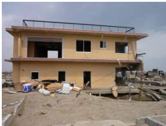
写真 1 RC 造壁式建物
