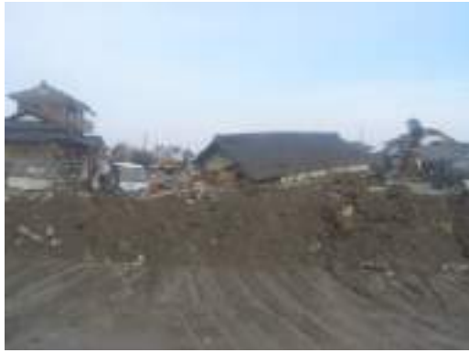
写真 6. 3. 12-1 住宅の移動及び転倒 (押分)
