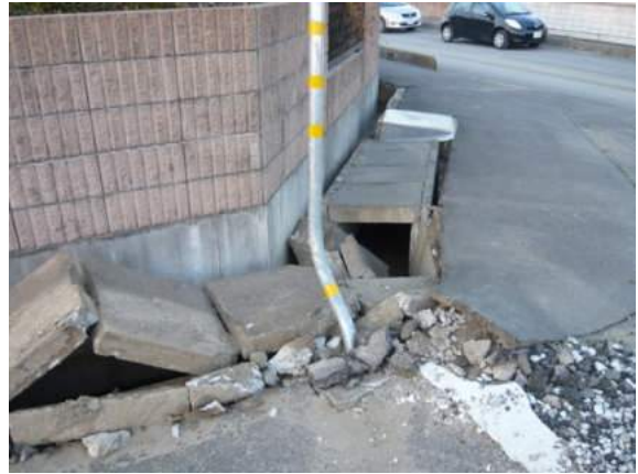
写真 5.5.2.1-40 側溝の被害
