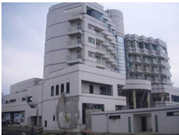
写真1 ホテルの外観
