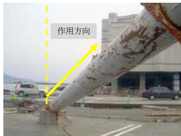
写真 6.2.1-1 棒状の工作物の津波による折損状況
