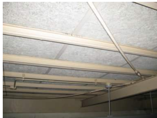
写真 5.3-26 ターンバックルのたわみ (MIT-27)
