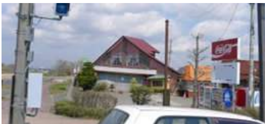
写真 5.2.2-23 地盤変状に伴い傾斜した店舗
