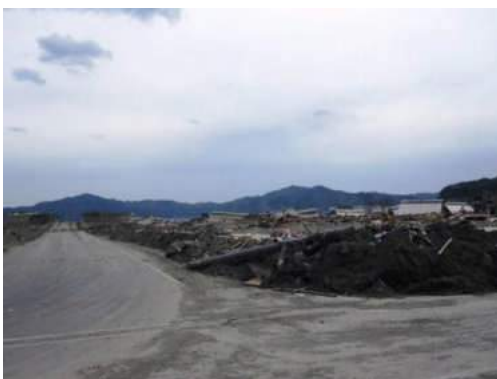
写真 14 破壊された近所の防潮堤
