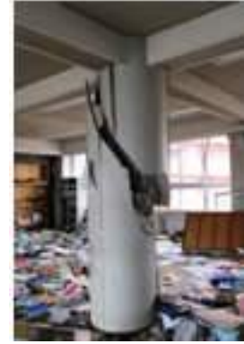
写真 5.4-52 3階柱の破壊
