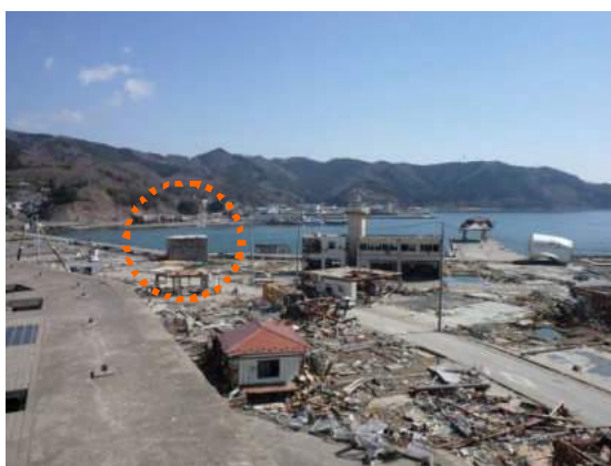
写真 1 転倒建物 (丸印、海側に転倒)
