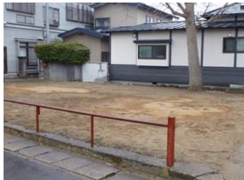
写真 5.2.1-3 液状化による噴砂痕
