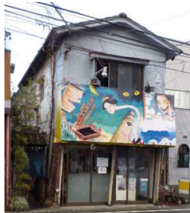
写真 5.2.5-10 残留変形の大きな木造 （仙台市青葉区小松島）
