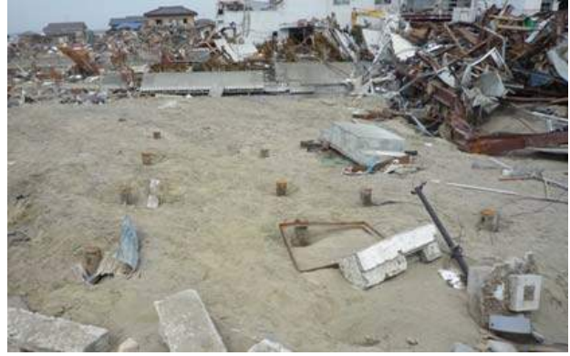
写真 6. 3. 11-2 写真 6. 3. 11-2 の当初位置に残る杭
