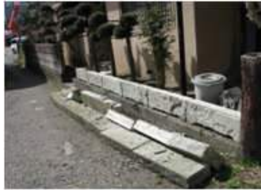
写真 5.4-160 石塀の倒壊
