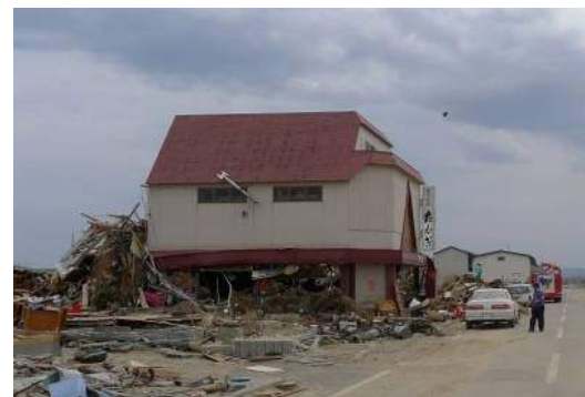
写真 6. 3. 13-26 残存する鉄骨造店舗 (18)
