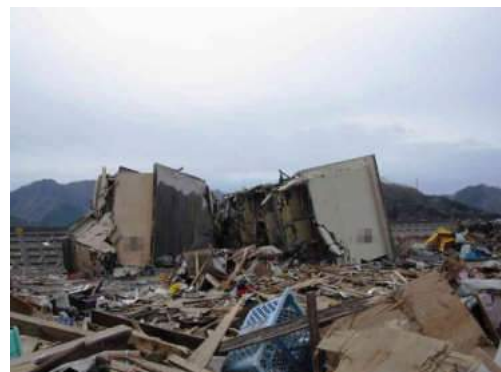
写真 6.4.1-8 集合住宅の転倒(CB造)
