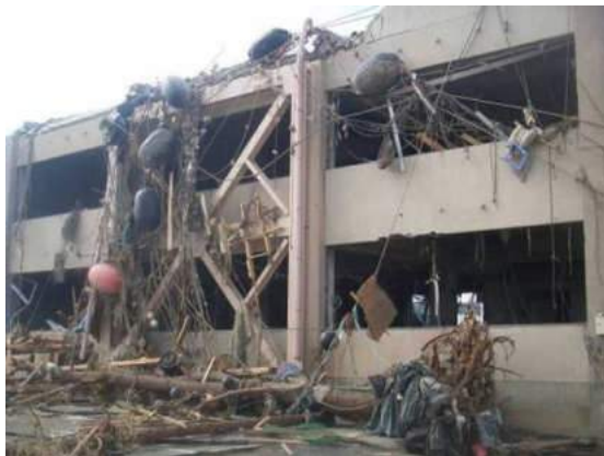
写真3 建築物外観 (東面)
