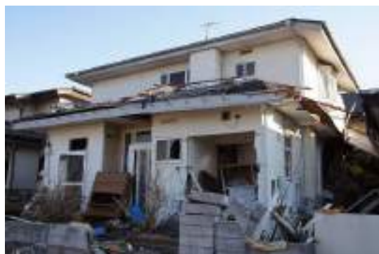
写真 6.3.10-41 残存する木造建物
