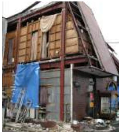
写真 5. 6-6 (左) 写真 5. 6-7 (右) ALC パネルの脱落被害
