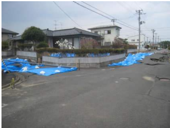
写真 5.5.2.3-41 高台の端部斜面②の地すべりに関連すると思しき地盤変状による宅地被害
