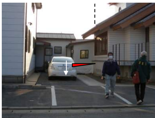
写真 5.5.2.1-36 接続部分の損傷及び駐車場
