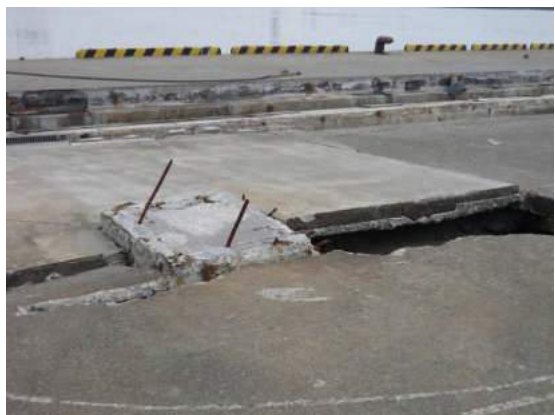
写真3 独立柱 (1本だけ残存、他は流失)
