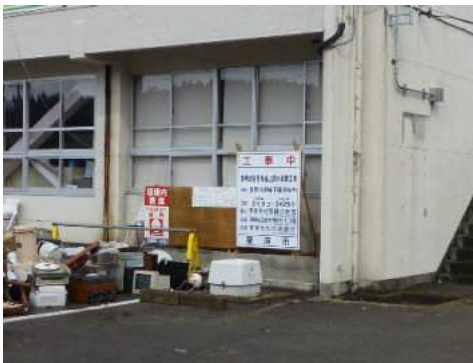
写真 5.2.1-23 瀬峰の震度計設置状況
