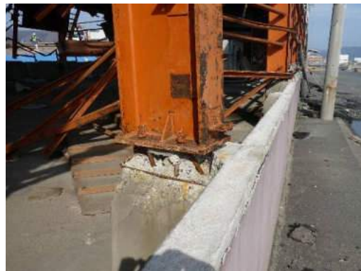
写真 6.4.2-25 柱の変形（石巻市） （コンクリート塊や道路の舗装アスファルト等の漂流物によると考えられる）
