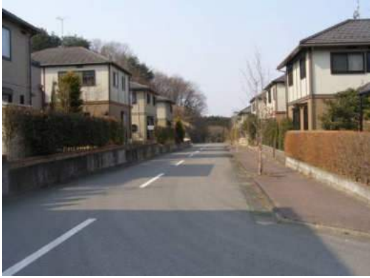
写真 5.2.8-3 ロビンシティ地区の 無被害住宅
