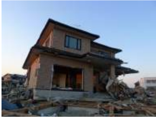
写真 6. 3. 11-1 基礎ごと流された木造 (①)
