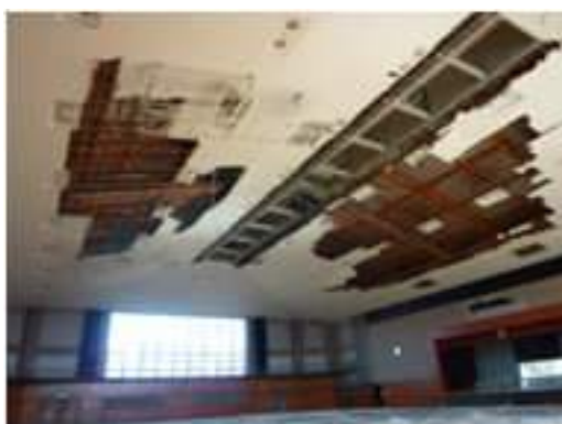
写真 5.4-206 天井の脱落1
