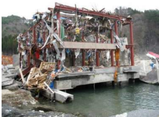
写真 6.4.2-20 残存するS造（釜石市両石） （洗掘を受けて基礎杭まで見える。）
