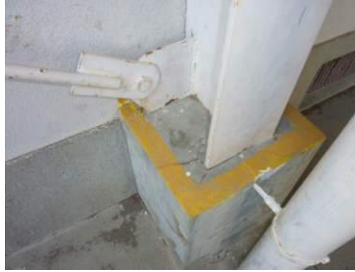
写真 5.3-34 亀裂 (MIT-22)
