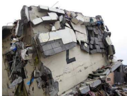
写真 11 移動し転倒した住棟 3 (上下逆になっている)
