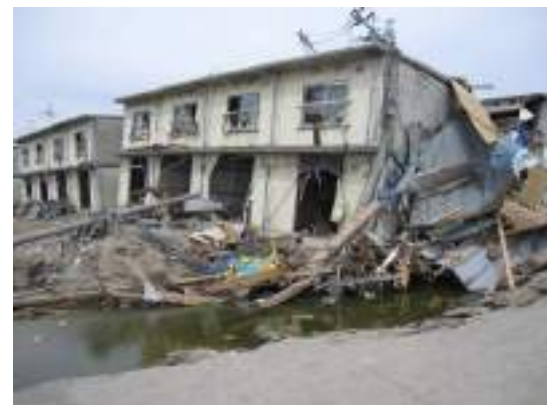
写真 6.3.11-28 周辺地盤の洗掘による建物傾斜 (17)
