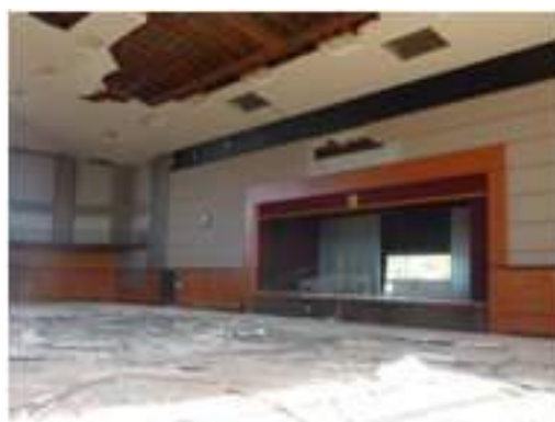
写真 5.4-207 天井の脱落2
