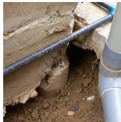
写真 5.5.2.1-12 建物角部の支持構造物
