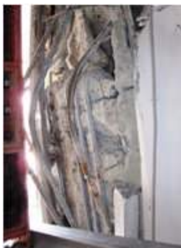
写真 5.4-141 柱段落とし部詳細
