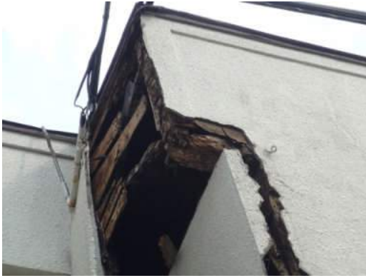
写真 5.2.6-9 写真 5.2.6-8 で外壁モルタル
