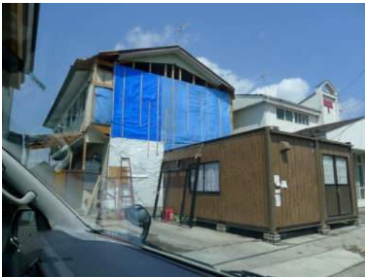
写真 5.2.2-20 前面部分が解体済みの木造
