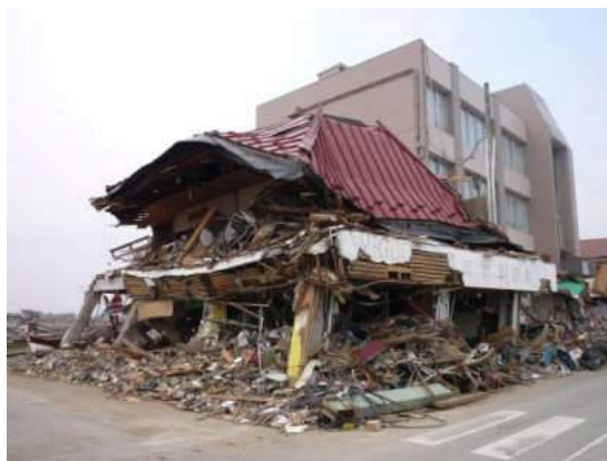
写真2 倒壊した建物 (正面)
