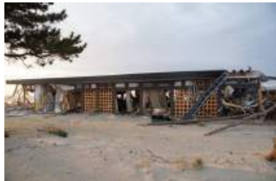
写真 6.3.13-8 写真 6.3.13-7 の桁行方向 (面格子壁)
