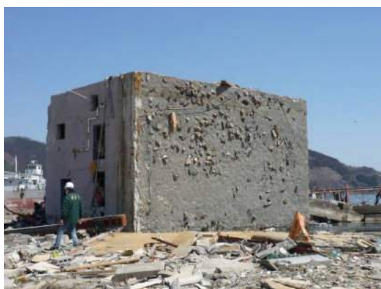
写真 2 建物底面 (直接基礎)
