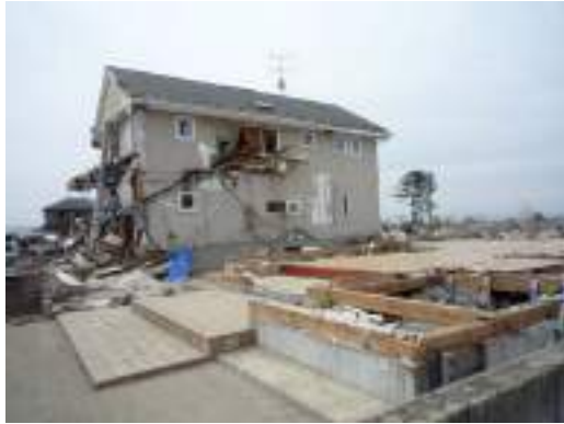
写真 6.3.11-14 写真 6.3.11-13 の北側外観
