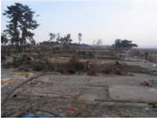
写真 6.3.12-9 基礎と土台のみが残った住宅地 (寺島地区南部)
