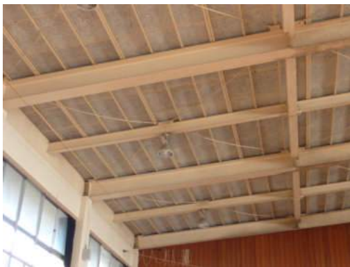
写真 5.3-27 ターンバックルのたわみ(MIT-25)
