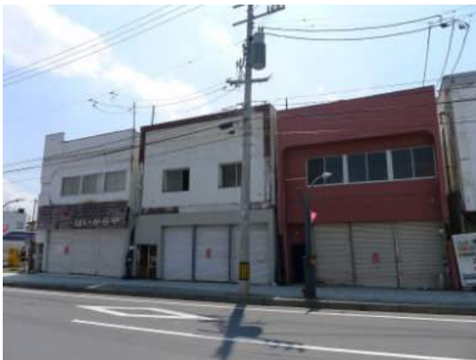
写真 5.2.2-29 傾斜した店舗併用住宅 3 棟
