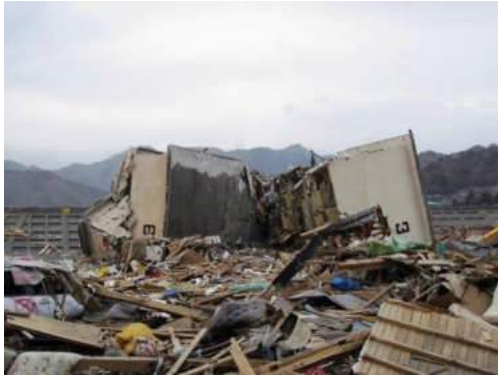
写真 8 移動し転倒した住棟 2 棟
