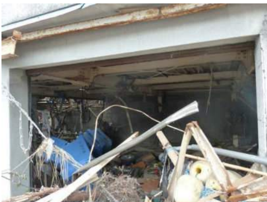
写真3 内部のコンクリートブロック壁
