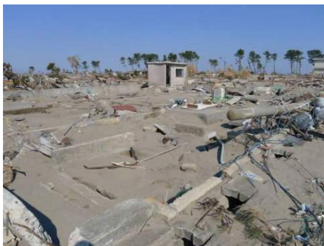
写真 6.4.3-2 上部構造と土台も流失した例
