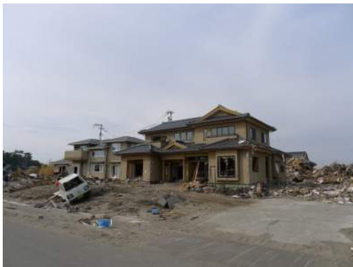
写真 6. 3. 11-56 残存した木造と鉄骨造住宅 (④)
