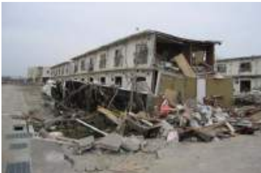
写真 6.3.11-25 建物東端 1戸分の崩壊 (16)
