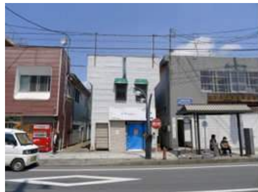
写真 5.2.2-30 傾斜した店舗併用住宅
