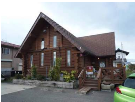
写真 5.2.3-7 外観無被害のログハウス 店舗
