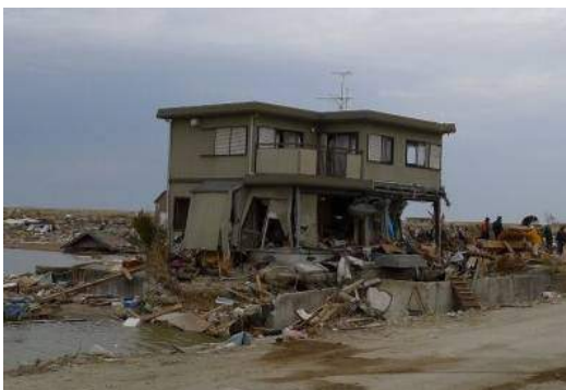
写真 6. 3. 13-25 残存する軽量鉄骨造住宅 (17)
