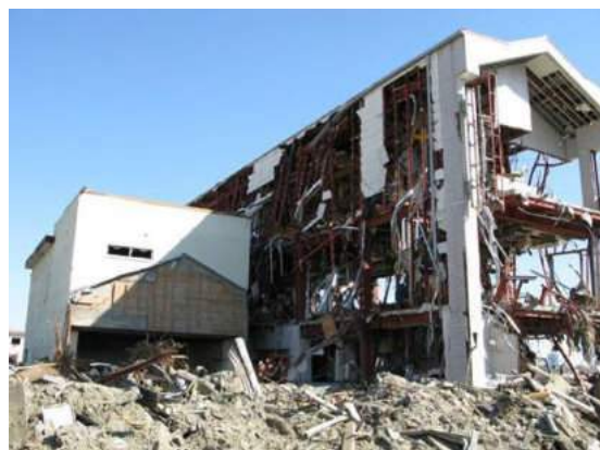
写真4 隣接するRC建物
