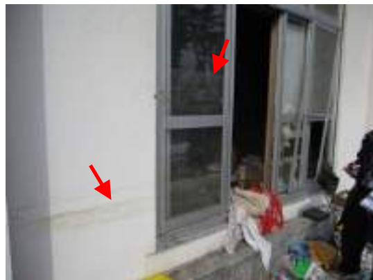
写真 6. 3. 11-64 1階の浸水痕
