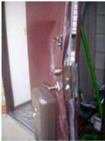
写真 5.4-98 玄関ドアの変形
