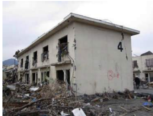
写真2 残存した住棟
