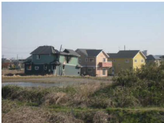
写真 5.5.2.1-49 液状化により傾斜した戸建て住宅群（手前の1棟は火災による被害か）
