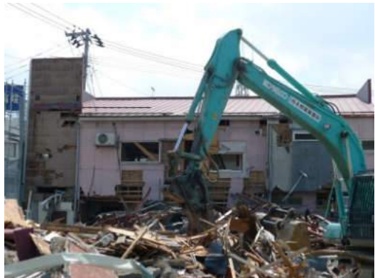
写真 5.2.2-34 解体工事中の木造住宅
