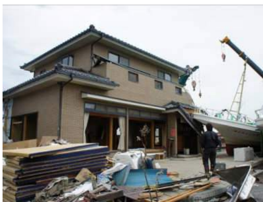
写真 6. 4. 3-5 津波の作用方向に開口が多く残存したと考えられる事例
