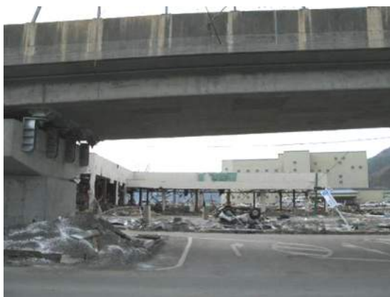
写真1 建物外観(1) (上は釜石バイパス)
