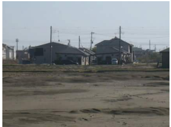
写真 5.5.2.1-48 液状化により傾斜した戸建て住宅群
