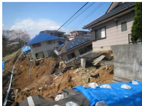
写真 5.5.2.3-46 丘陵の南西側の斜面地①の地すべりと滑り落ちかけた住宅
