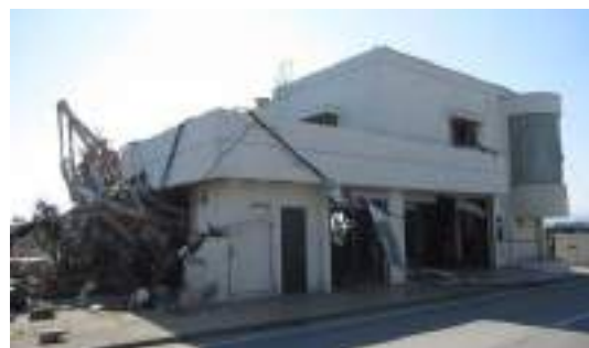
写真 6.3.10-8 住宅の外観 (②)
