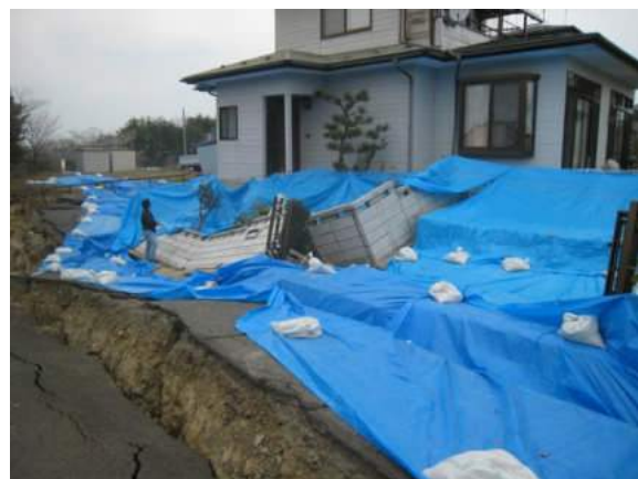
写真 5.5.2.3-38 写真 5.5.2.3-37 の地すべりに伴う地盤変状により被災した住宅
