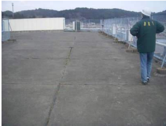
写真5 屋上の様子（浸水の形跡は認められない）
