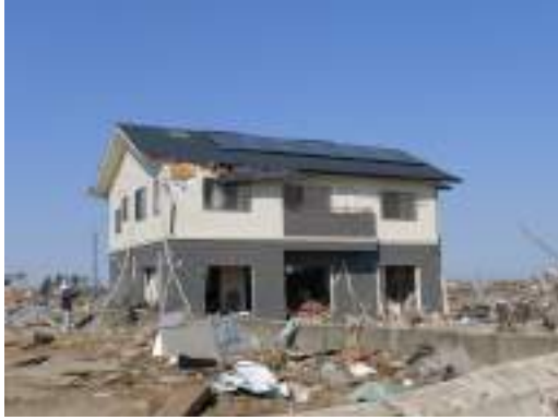
写真 6. 3. 10-19 残存した木造住宅 (⑧)
