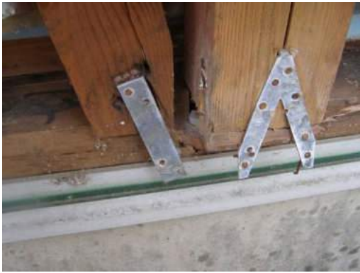
写真 5.2.7-9 写真 5.2.7-8 の柱脚及び筋かい端部
