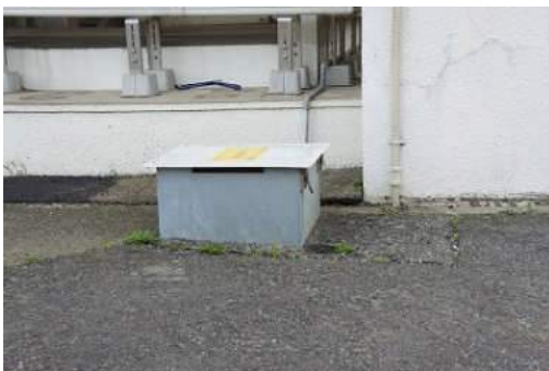
写真 5.2.13-1 龍ヶ崎市震度計設置状況
