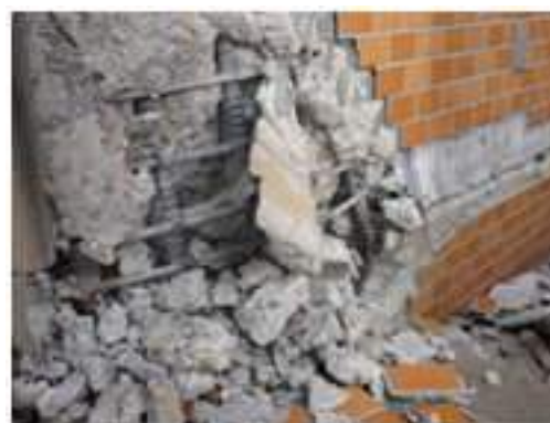
写真 5.4-95 1階柱脚部の破壊状況
