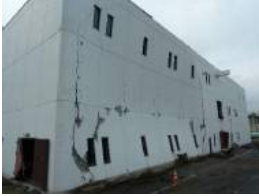
写真 6. 3. 10-44 第3 ポンプ室 外観
