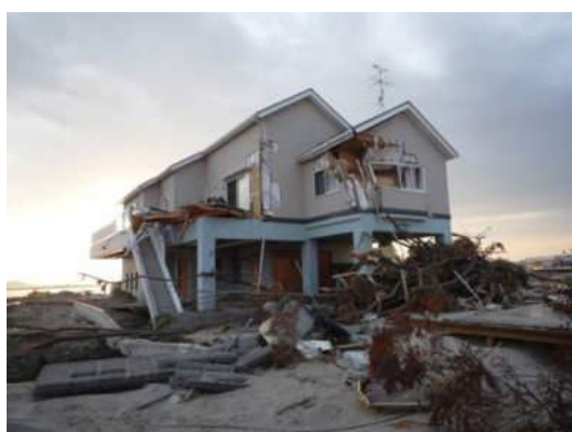
写真 6. 4. 3-7 1階 RCピロティー構造の事例
