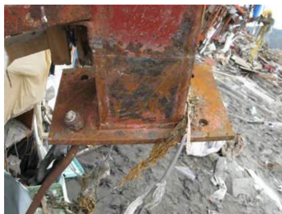
写真4 柱脚ベースプレート
