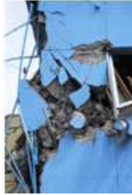
写真 5.4-51 2階柱の破壊
