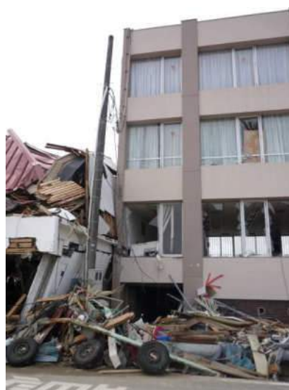
写真4 妻壁の損傷
