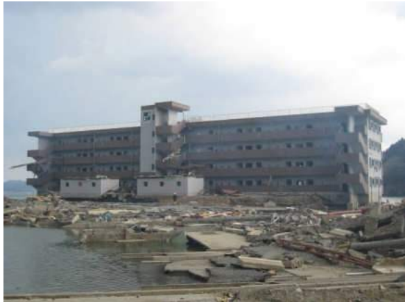
写真1 建築物の外観
