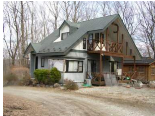
写真 5.2.7-12 窓ガラスの割れ (豊原乙地区)
