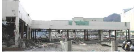
写真 6.5.2-1 残存 S 造骨組み
