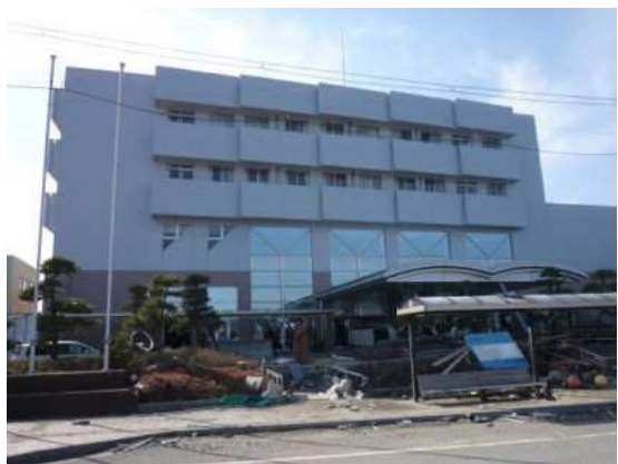
写真4 建物（東面、港側）
