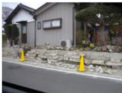
写真 5.4-186 倒壊した塀 1
