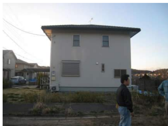
写真 5.5.2.3-52 写真 5.5.2.3-51 の住宅（沼地側（紙面の右側）に傾斜している）
