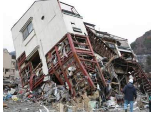
写真 6.4.2-8 3階建てS造の転倒（女川町） 写真 6.4.2-9 3階建てS造の1階の崩壊（大槌町）
