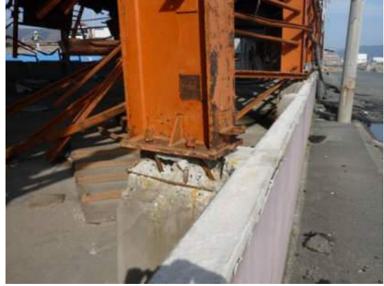
写真 6 柱脚アンカーボルト部分（倉庫 2）
