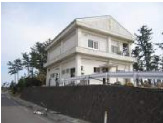
写真 6. 3. 11-63 建物外観 (⑨)
