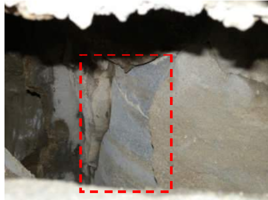
写真 5.5.2.1-23 杭周固定液の内部
