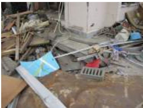
写真 6. 3. 14-9 周辺地盤の洗掘
