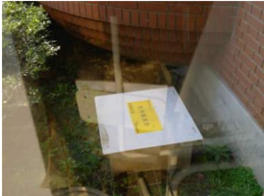
写真5.2.10-12 震度計設置状況(瓜連支所)
