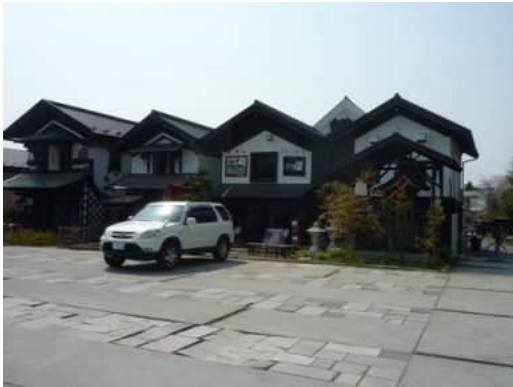
写真 5.2.2-1 大小の被害を受けた土蔵群
