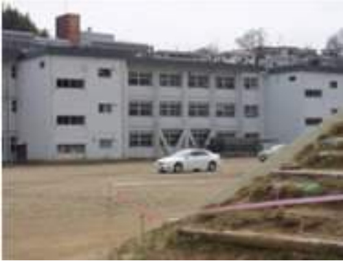
写真 5.4-84 C 小学校校舎外観
