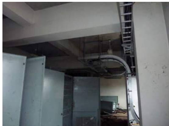
写真 4 2階床を有する棟の内部
