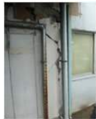
写真 5.4-49 曲げ破壊
