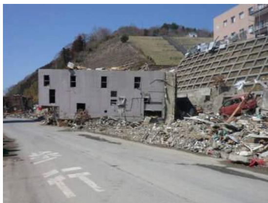
写真1 移動・転倒した建物
