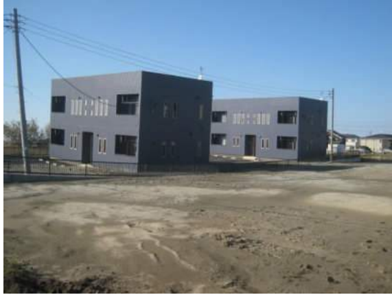
写真 5.5.2.1-45 液状化による宅地盛土および小型集合住宅の沈下・傾斜
