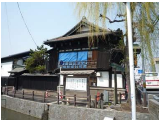
写真 5.2.2-3 店舗として活用されている伝統的構法による民家の被災例
