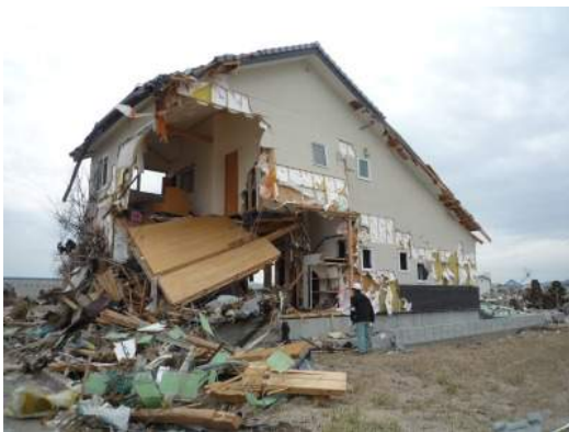
写真 6. 3. 13-23 残存する木造住宅 (15)
