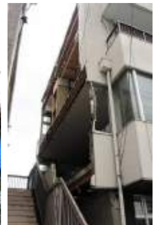
写真 5. 6-6 (左) 写真 5. 6-7 (右) ALC パネルの脱落被害
