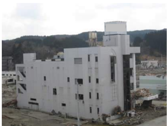
写真2 建築物外観 (東面)
