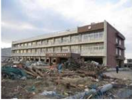
写真 6. 3. 13-37 荒浜中学校建物外観 (㊸)
