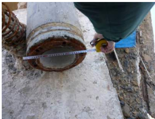
写真 4 PC 杭と杭頭中詰め部
