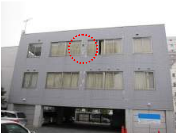
写真 5.6-30 ALC パネル外壁の被害
