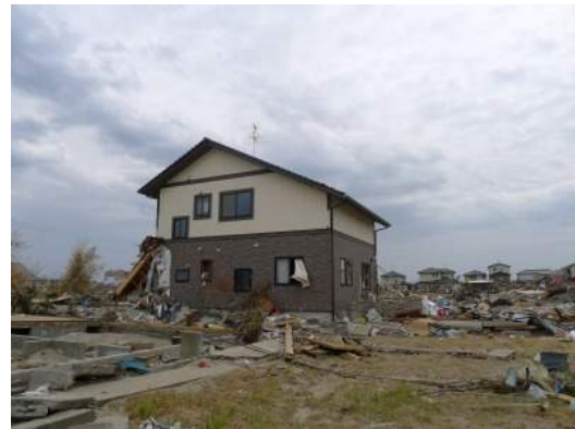
写真 6. 3. 13-24 残存する木造住宅 (16)
