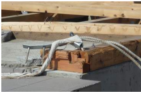
写真 6.3.10-3 写真 6.3.10-2に残る ホールダウン金物
