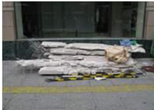
写真 5.4-6 落下したALC パネル
