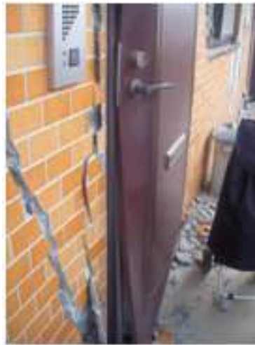
写真 5.4-98 玄関ドアの変形
