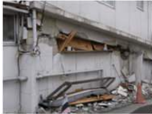
写真 5.4-152 崩壊部分
