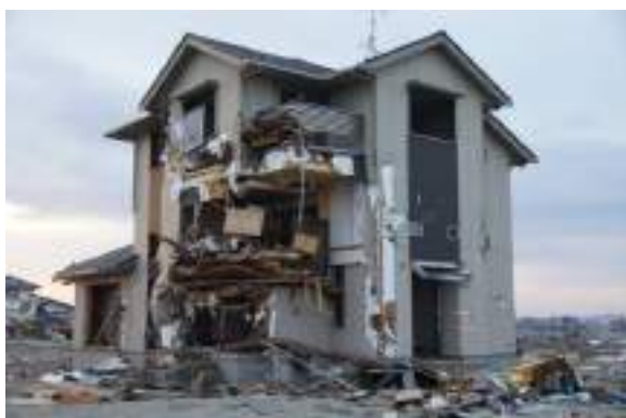
写真 6. 3. 13-11 残存する 3 階建木造住宅 (④)
