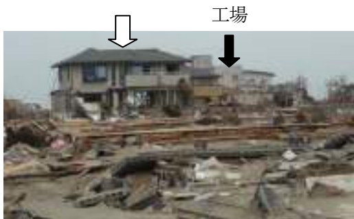
写真 6.3.11-16 津波作用方向から見た工場建築物の反対側で流失を免れた木造家屋 (⑫)
