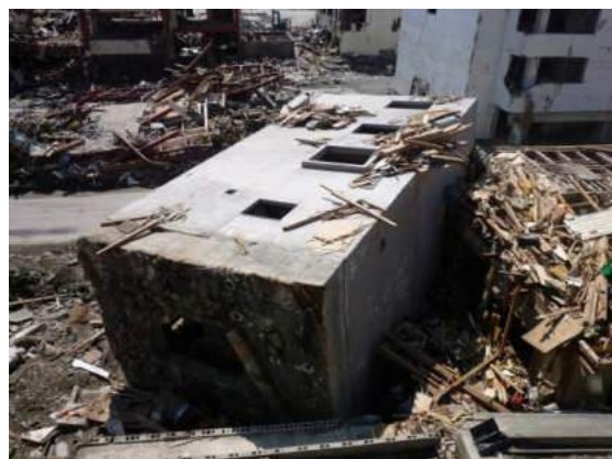
写真1 移動・転倒した建物
