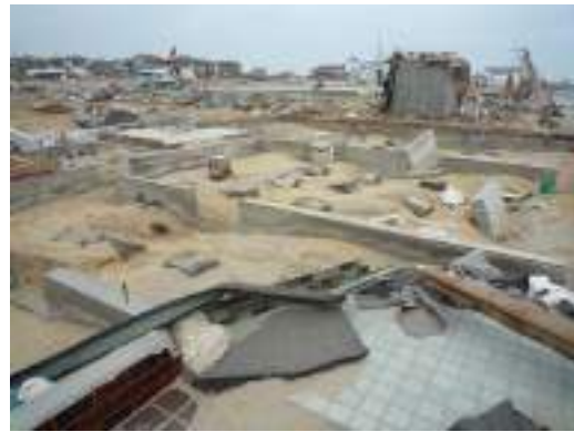
写真 6. 3. 13-16 混構造の北隣りの家屋流失 (㉘)
