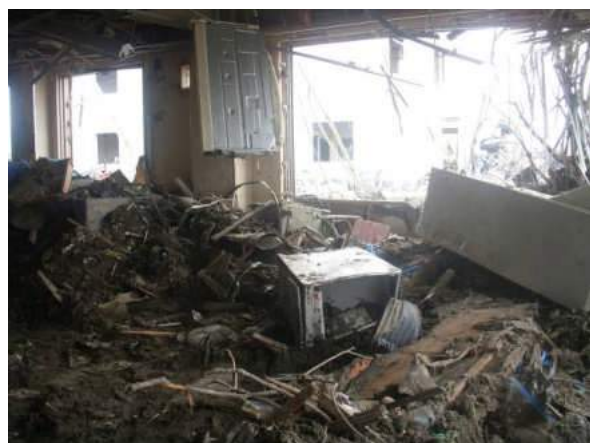
写真2 1階内部の状況
