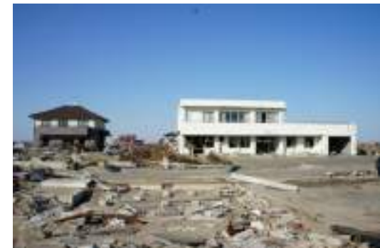
写真 6. 3. 10-24 荒浜コミュニティセンターとの位置関係 (南から撮影)
