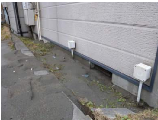
写真 5.5.2.1-31 基礎部分の外観（1）
