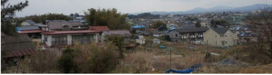
写真 5.2.6-24 南町から東側一帯の概況（ブルーシートをかぶせた屋根が多い）
