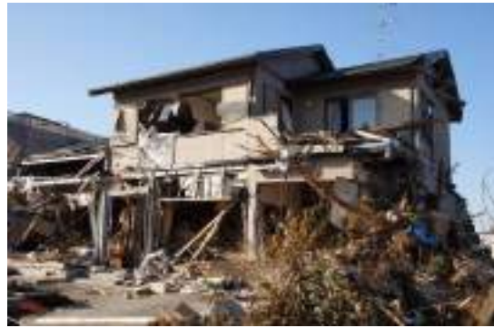
写真 6.3.10-36 残存する軽量鉄骨造建物(⑰)
