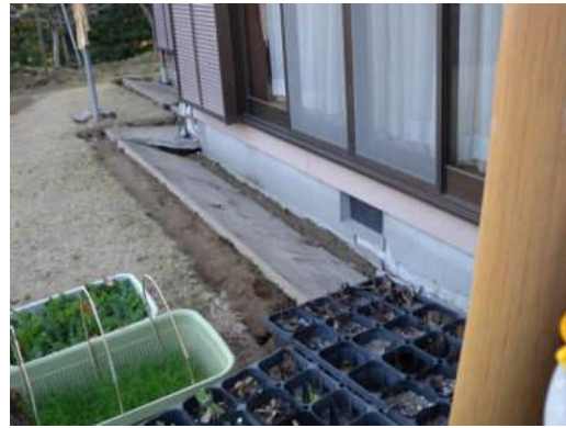
写真 5.5.2.1-38 基礎部分外観
