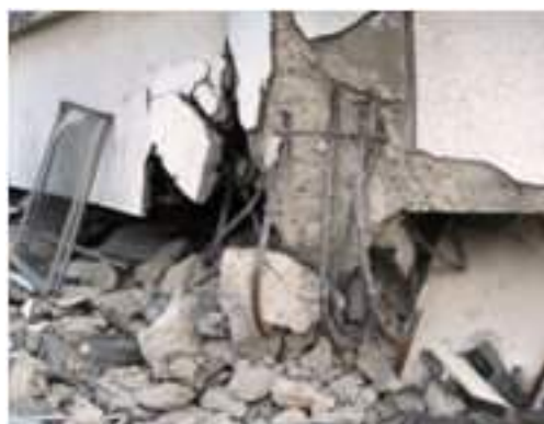
写真 5.4-132 隅柱の崩壊
