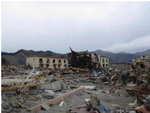
写真3 残存した住棟
