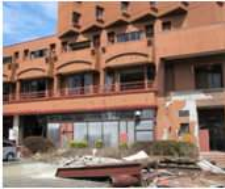
写真 5.4-169 RC造（一部SRC）の棟
