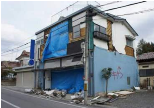
写真 5.2.6-3 店舗併用住宅の被害
