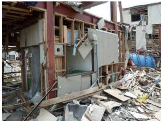
写真2 コンクリートブロック壁の区画
