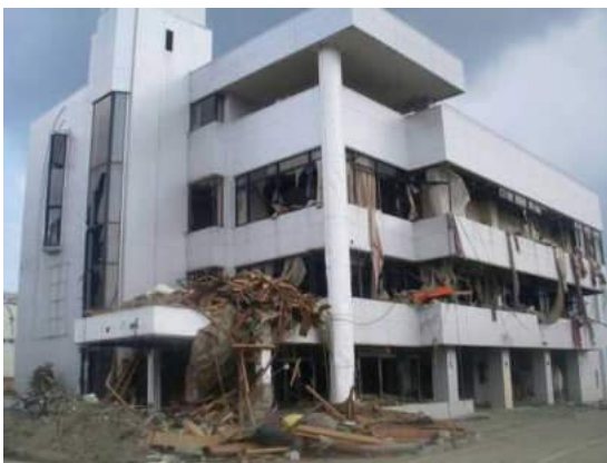
写真3 建築物外観 (南東面)
