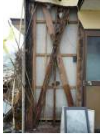
写真 6. 3. 13-14 写真 6. 3. 13-13 の筋かいの生物劣化
