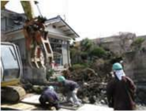
写真 5.4-159 被災したブロック塀（解体中）
