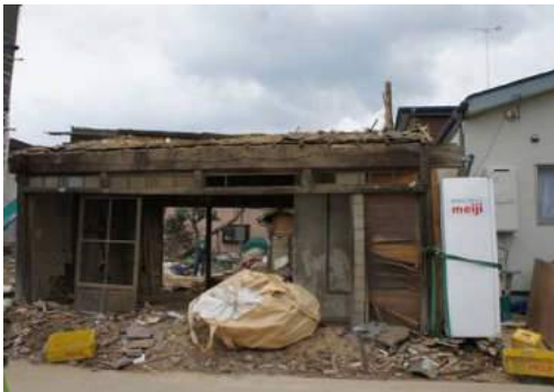
写真 5.2.6-23 解体撤去作業中の被災建築物
