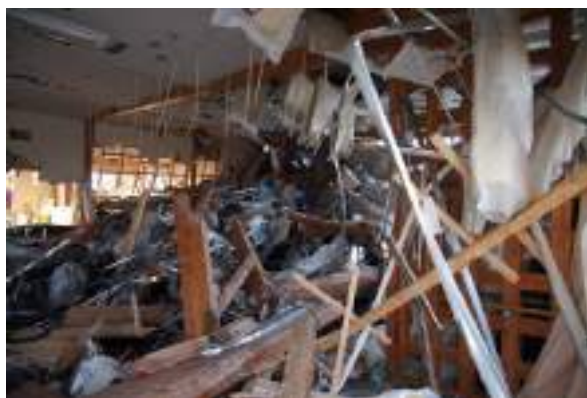
写真 6. 3. 13-10 写真 6. 3. 13-7 の建物内部
