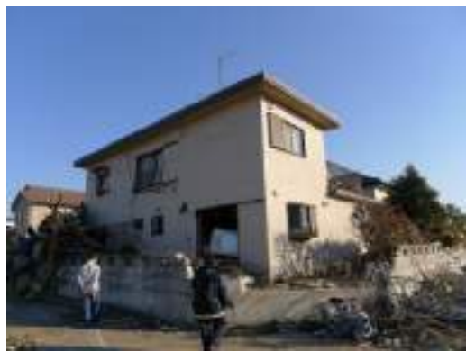
写真 6. 3. 10-30 残存する RC 造 (パネル) 住宅 (15)
