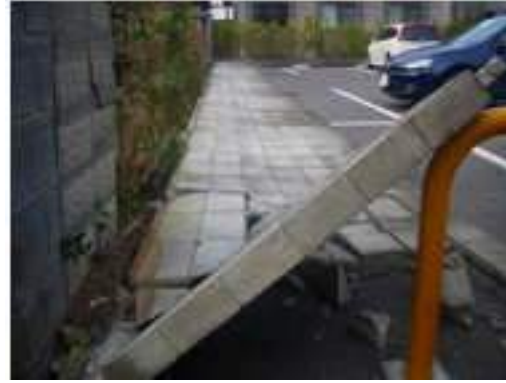
写真 5.4-112 コンクリートブロック塀の転倒 写真 5.4-113 コンクリートブロック塀の転倒
