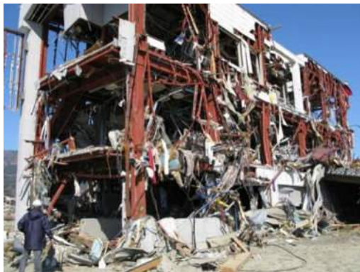
写真 6.4.2-15 残存する 3 階建て S 造 (陸前高田市)
