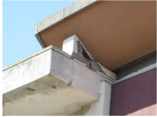
写真 5.3-24 外部の屋根支承部(MIT-26)
