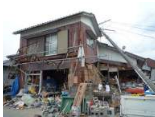
写真 6. 3. 13-18 津波作用方向から見た混構造の反対側で残った構造仕様が劣る住宅 (㉚)
