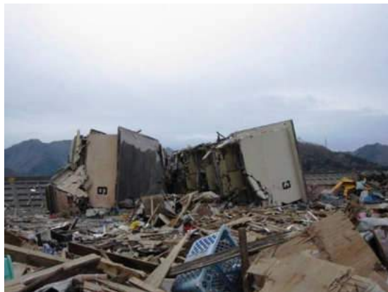
写真2 転倒した集合住宅棟
