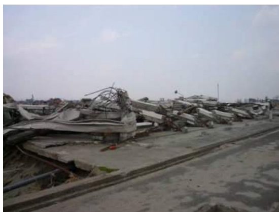
写真1 倒壊した建物
