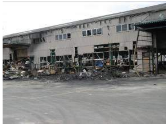
写真 7.3.1-4 仙台塩釜港北側の駐車場2の火災
