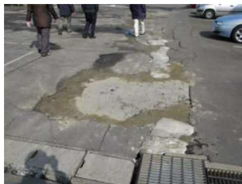
(b) 駐車場の亀裂と噴砂の跡
