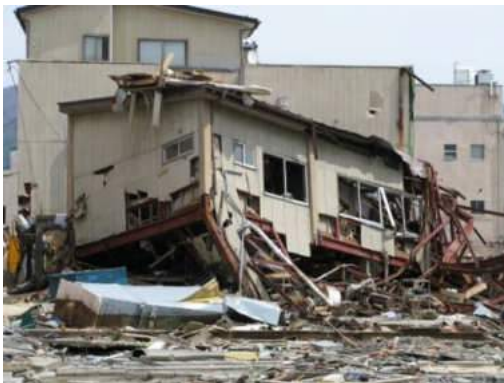
写真 6.4.2-10 2階建てS造の1階の崩壊（大船渡市） 写真 6.4.2-11 部分的な崩壊（釜石市）
