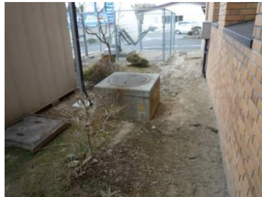
写真 5.2.6-28 震度計設置状況
