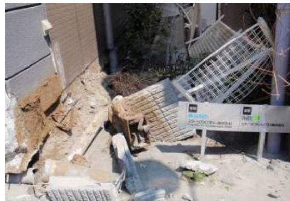
建物間の状況
