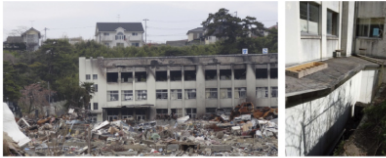
図3 津波避難ビルに延焼し裏山に再避難した事例 (石巻市立門脇小学校、左:筆者撮影、右 4) )
