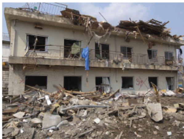
図 5 津波が建物に残した瓦礫
