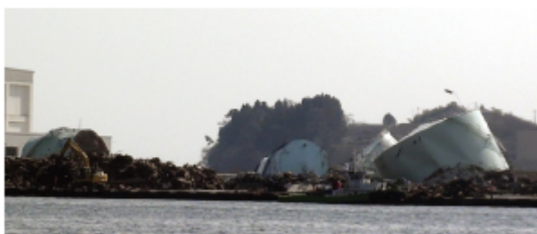
図 2 南気仙沼地区のオイルタンク
