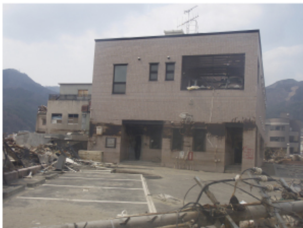
図3 石油の付着痕が見られる大船渡の建物
