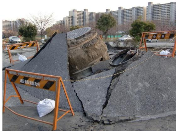
写真2 耐震性貯水槽の浮き上がり
