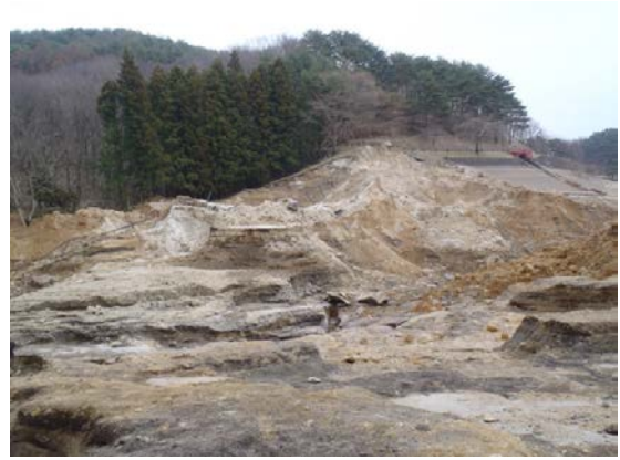
写真-4 ダム右岸側
