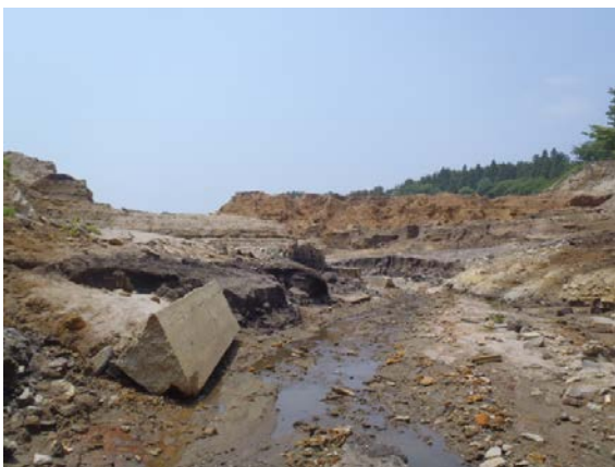
写真-1 ダム決壊正面
