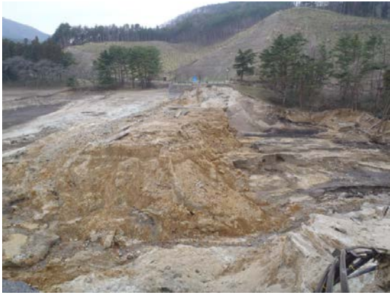
写真-3 ダム左岸側
