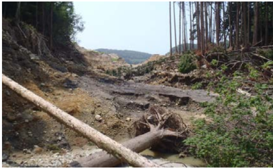
写真-5 ダム直下の河道状況
