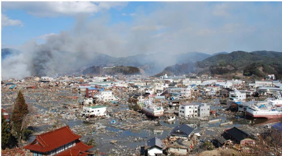
写真-4 鹿折地区 被害状況(3月12日)
