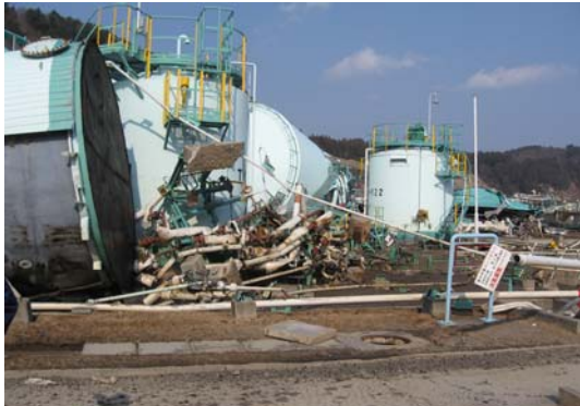
地上施設が壊滅した久慈国家石油備蓄基地
