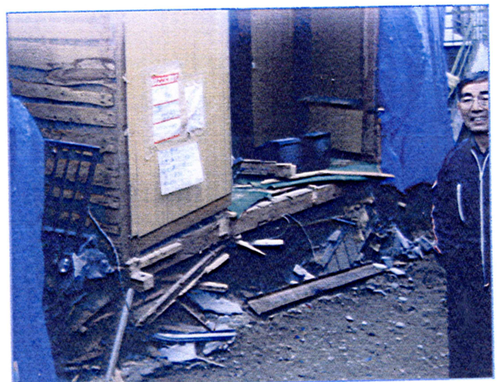
【写真⑦】危険なため、下敷きになっていたバイク2台、 を取り出すのにこの部分のみ先に切り取り。 後は解体の順番待ち。
