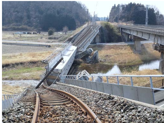
管内調査（常磐線双葉町前田地内）
